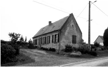
Vue d'ensemble depuis le nord-est. Phot. Thierry Lefébure IVR22_19920201064Z
