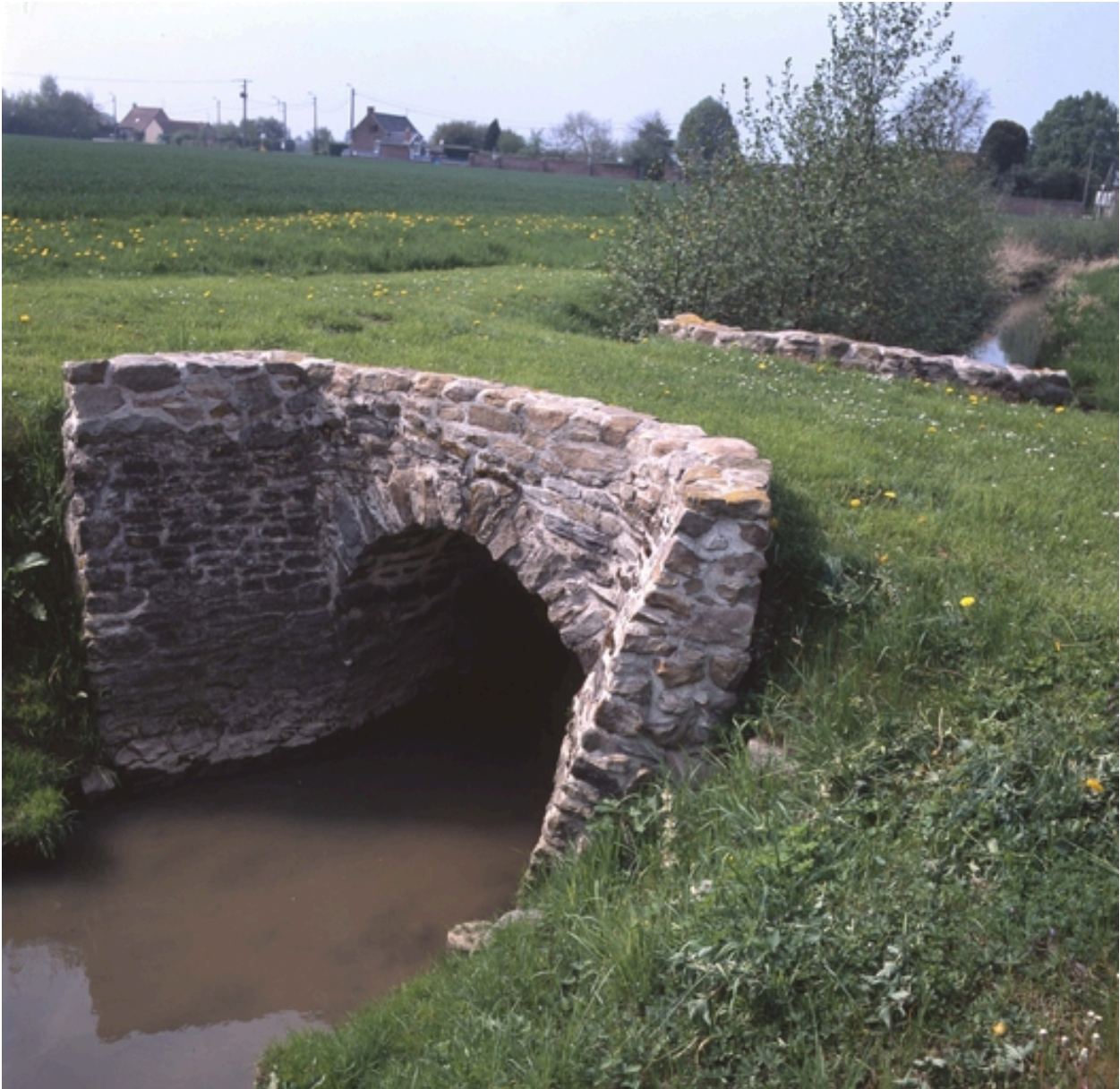
Vue générale du ponceau après restauration.
