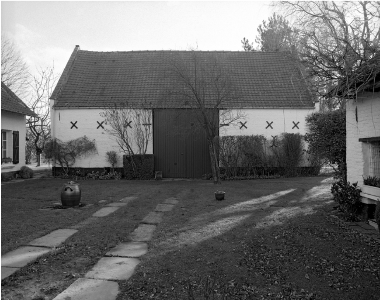
Vue générale avant restauration.
