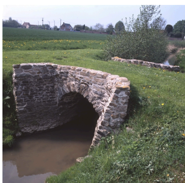
Vue générale du ponceau après restauration. Phot. Pierre Thibaut IVR31_20095902069XA
