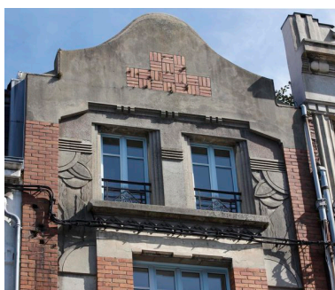
Ensemble des décors géométriques. Phot. Pierre Thibaut IVR31_20096200246NUCA
