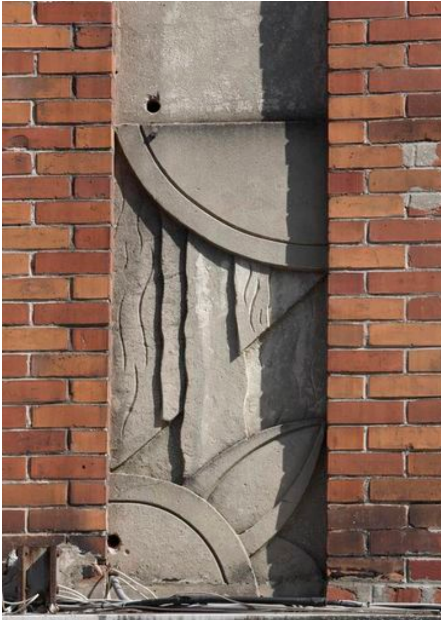
Extrémité d'une chaîne verticale en béton constituée de décors circulaires et de vagues.
