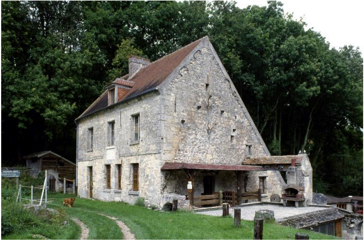
Vue du moulin depuis le sud-ouest.
