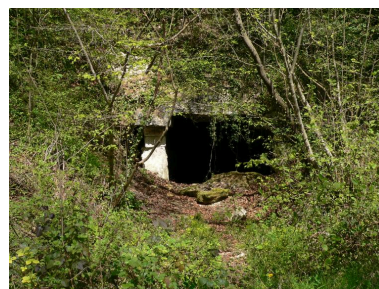
Vue de l'entrée d'une carrière, rue du Bois. Phot. Christiane Riboulleau IVR32_20180205074NUCA
