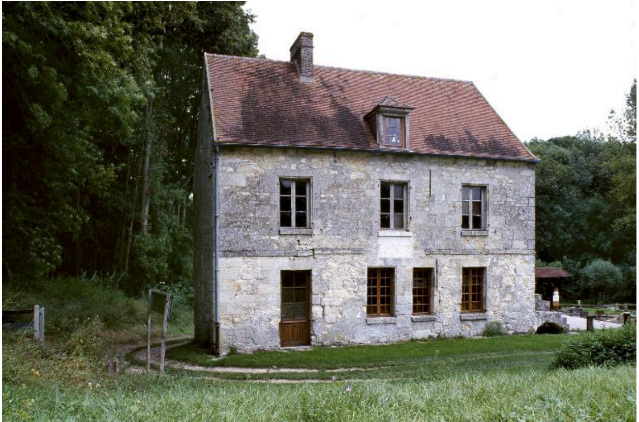
Vue de l'élévation occidentale du moulin.
