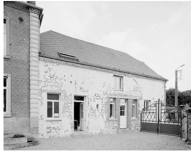
Vue du bâtiment abritant actuellement des bureaux. Phot. Pierre Thibaut IVR31_20055900601V
