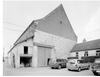
Vue de l'entrée de la grange. Phot. Pierre Thibaut IVR31_20055900600V
