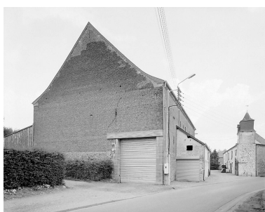
Vue de la grange depuis la rue de l'Hôpital. Phot. Pierre Thibaut IVR31_20055900598V
