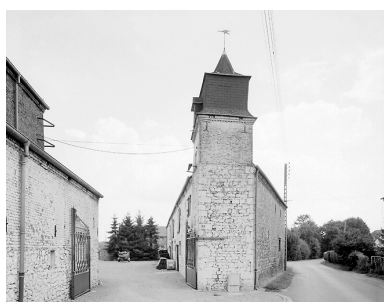
Entrée de la ferme avec la tour. Phot. Pierre Thibaut IVR31_20055900599V
