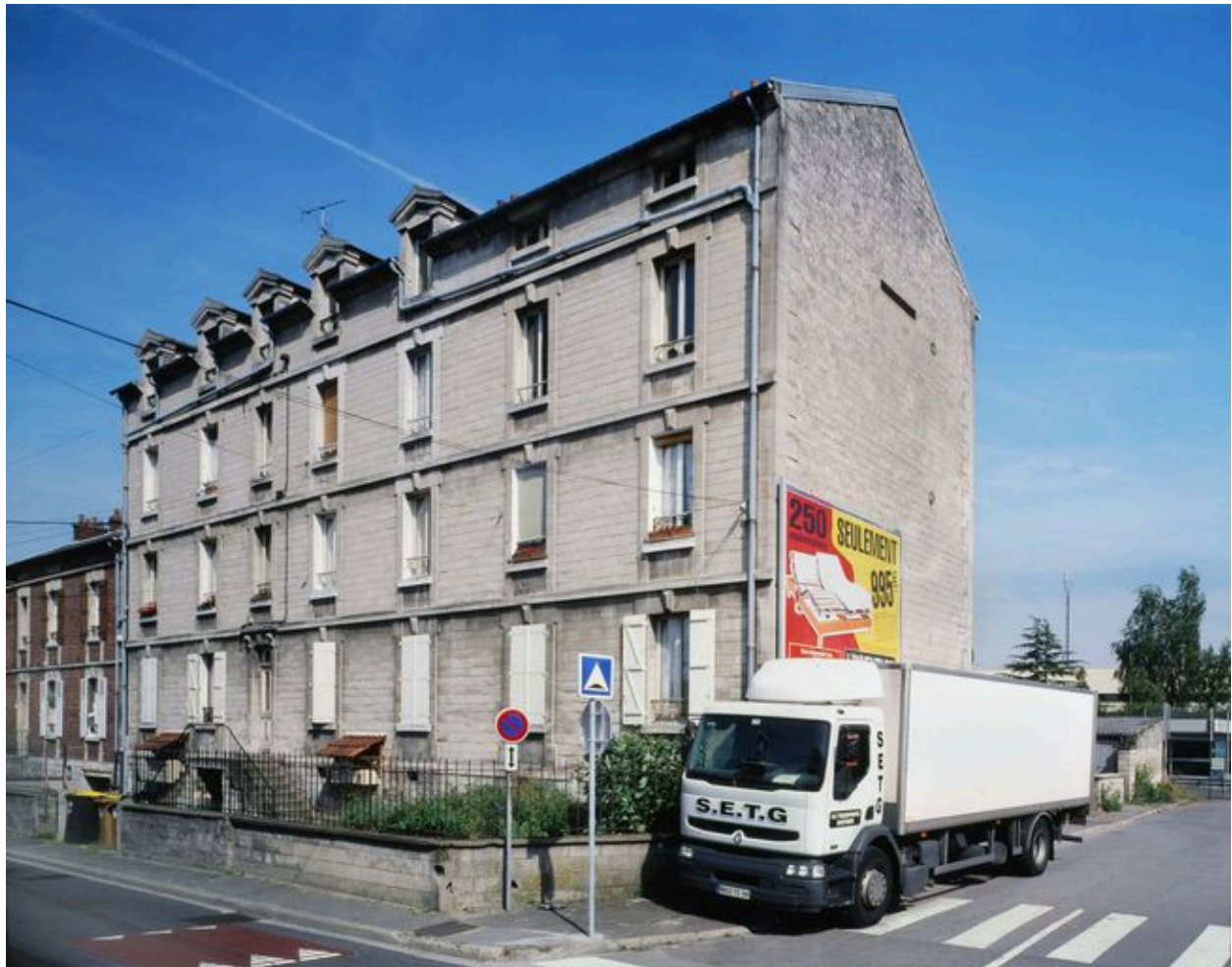
Barre de logements d'ouvriers de l'usine Chausson rue Louis-Blanc.
