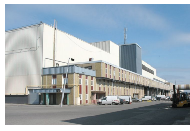
Anciens ateliers de tôlerie et de peinture et quais de déchargement. Phot. Clarisse Lorieux
