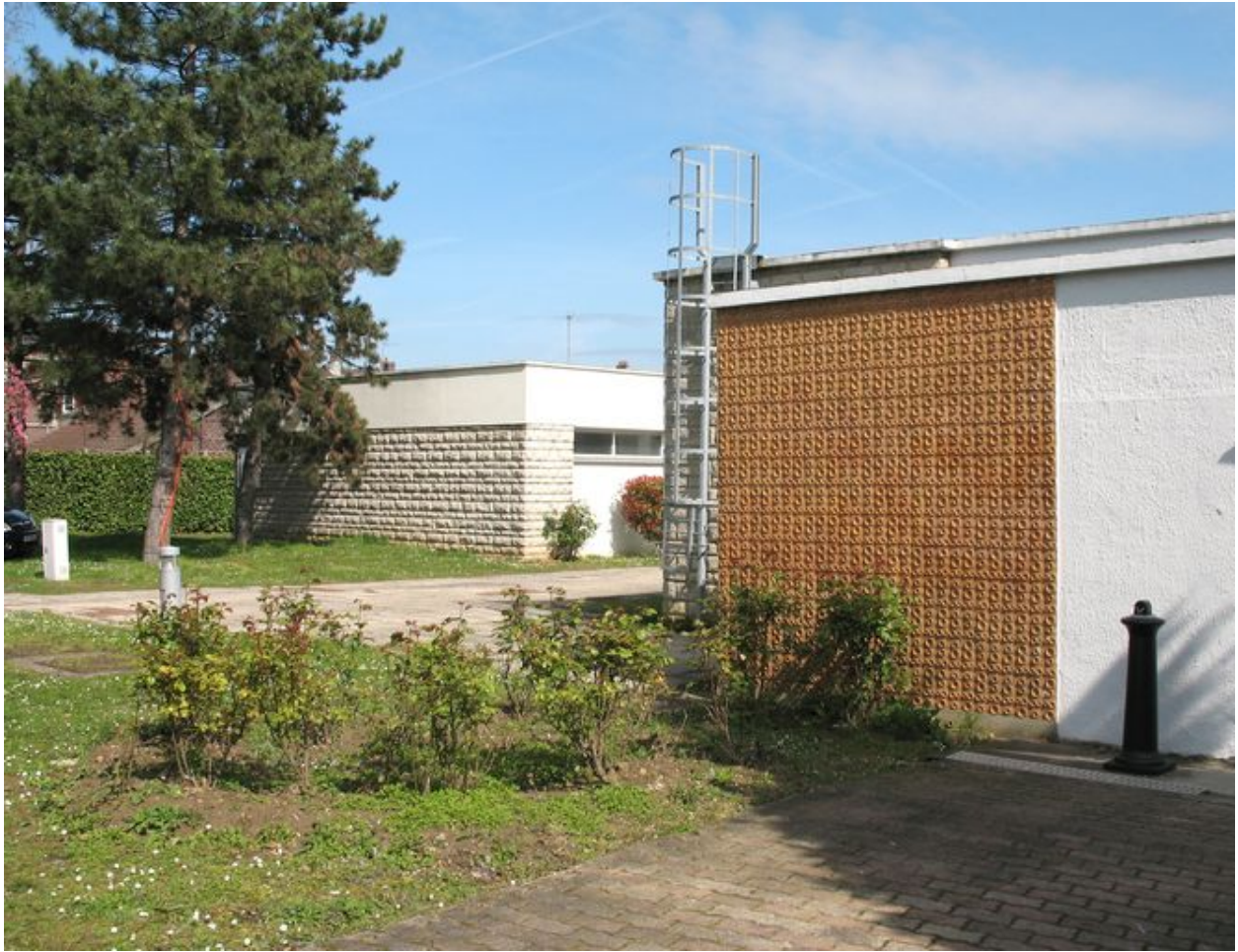
Détail des revêtements des murs du centre social.
