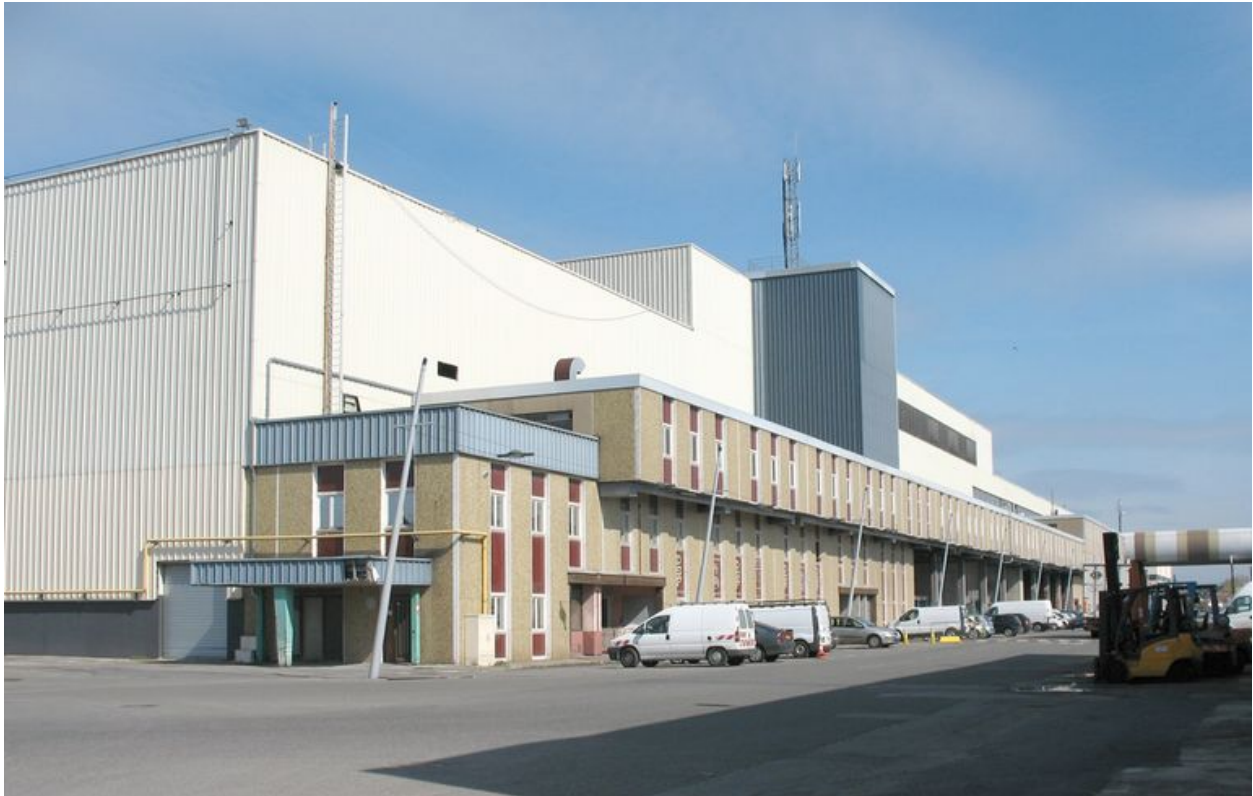
Anciens ateliers de tôlerie et de peinture et quais de déchargement.
