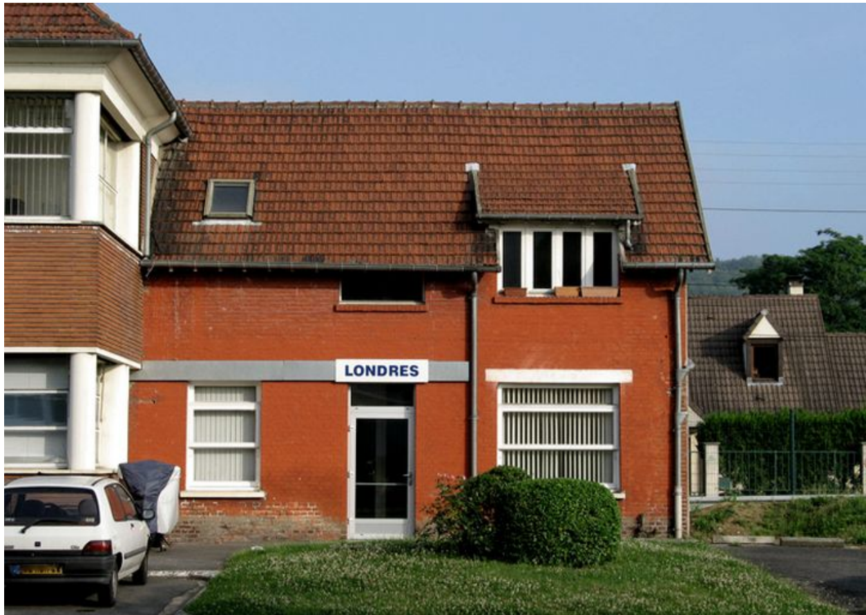
L'ancienne conciergerie de l'usine Fondu et Laverne (1903) transformée en infirmerie par l'usine Brissonneau et Lotz, état en 2007.
