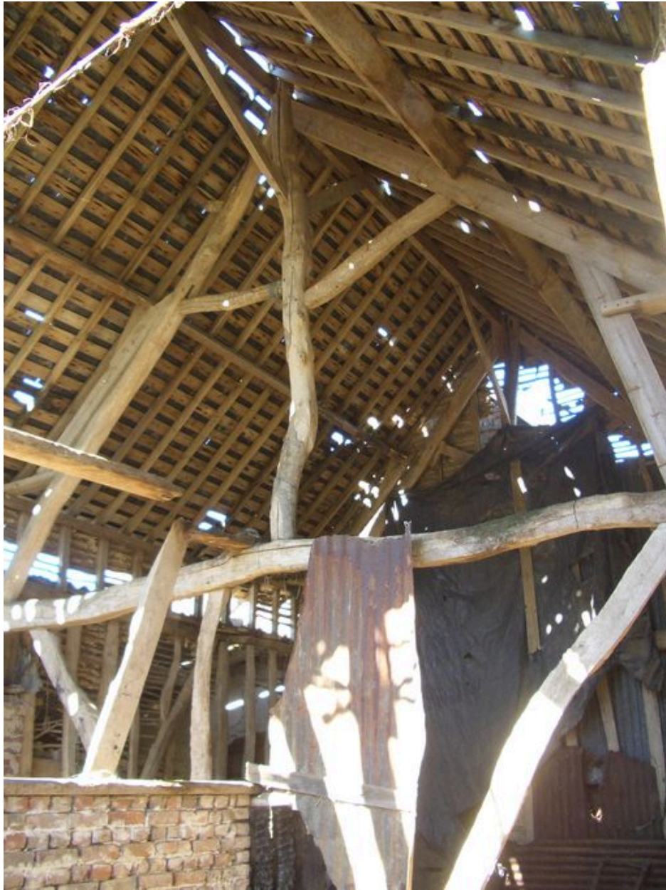
Vue détaillée d'une des fermes de la grange.
