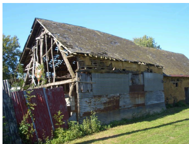
Vue de la grange. Phot. Inès Guérin IVR22_20078005267NUCA
