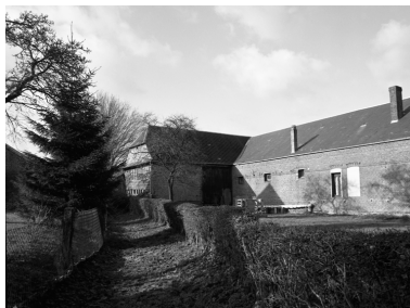
Vue de l'étable et de la grange, depuis le sud-est.
