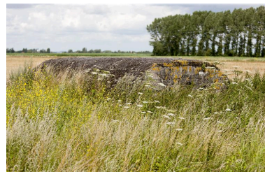
Vue vers le nord Phot. Jean-Marc Ramette IVR31_20145904228NUCA
