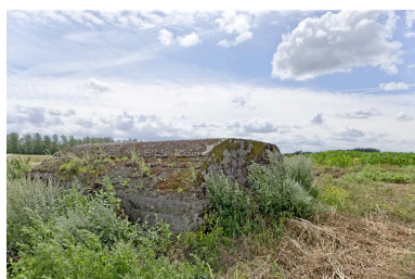
Vue vers le sud Phot. Jean-Marc Ramette IVR31_20145904230NUCA
