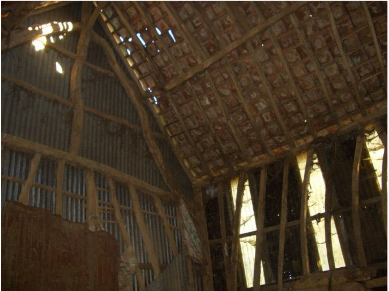
Vue intérieure de la grange.
