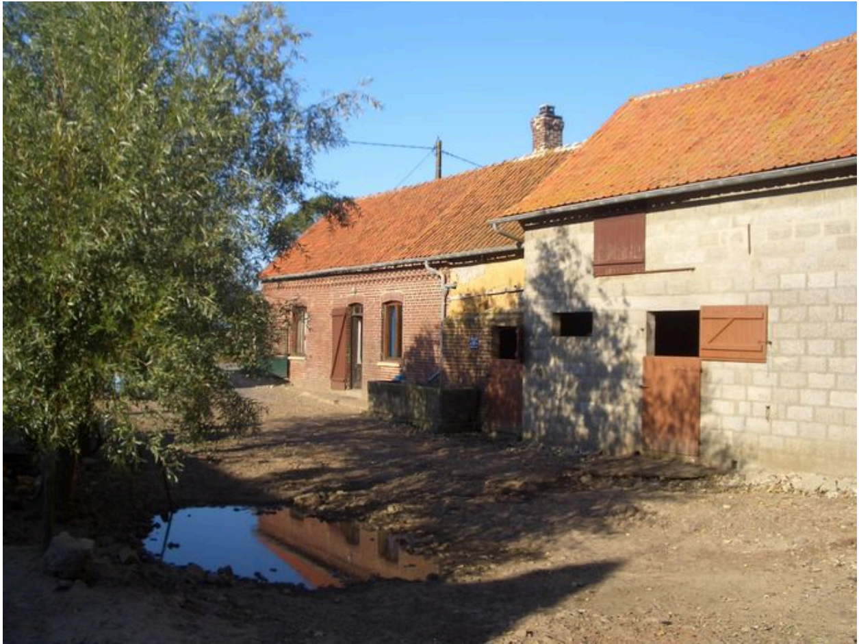
Vue de l'alignement du logis, de l'écurie et des étables.
