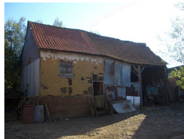
Vue de la grange en fond de cour. Phot. Inès Guérin IVR22_20068005326NUCA
