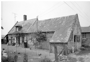
Elévation antérieure. Phot. Jean-Michel Perrin IVR22_19846001102X
