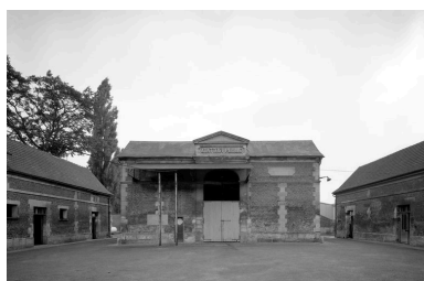
Façade principale de la tuerie et des bouvieries. Phot. Fabrice Charronnière IVR22_19856001439V
