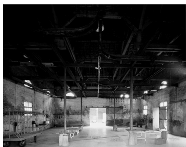
Tuerie : vue intérieure. Phot. Fabrice Charronnière IVR22_19856001437V
