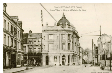
Vue de la place vers l'ouest et la rue de Tournai, le nouvel immeuble (reconstruction après la Première guerre) abritant la banque générale, carte postale, vers 1920 (Musée municipal Saint-Amand-les-Eaux). IVR31_20135908076NUCA
