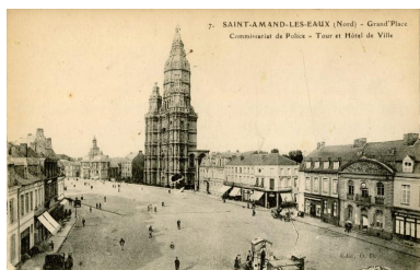
Vue générale de la place, côté est, hôtel de police, tour abbatiale et mairie (ancien échevinage), début du 20e siècle, carte postale (Musée municipal Saint-Amand-les-Eaux). IVR31_20135908071NUCA
