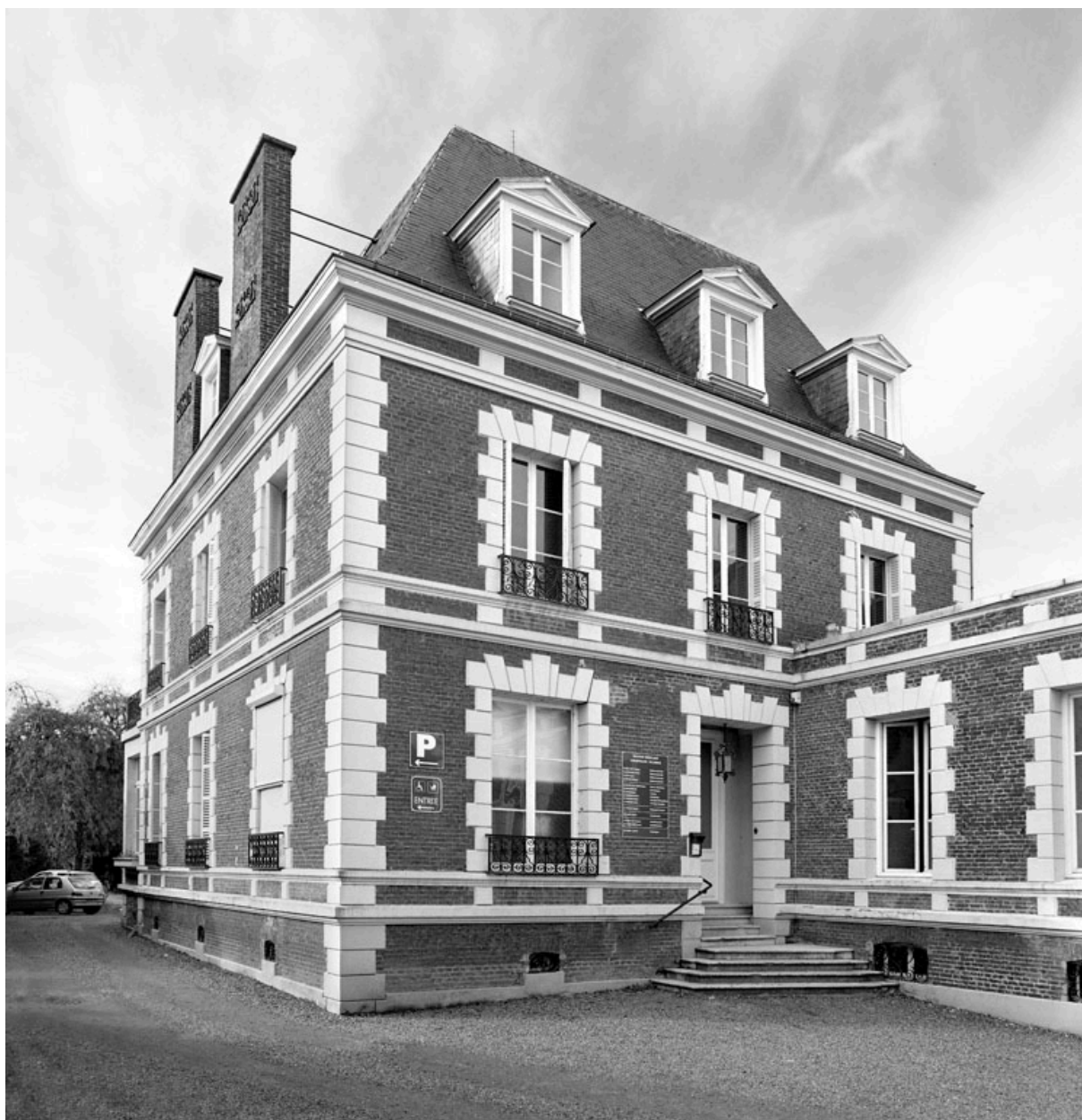
Vue des façades sur cour, depuis le portail.
