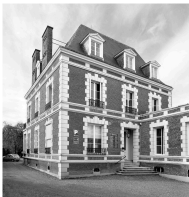
Vue des façades sur cour, depuis le portail. Phot. Thierry Lefébure IVR22_20020200848X
