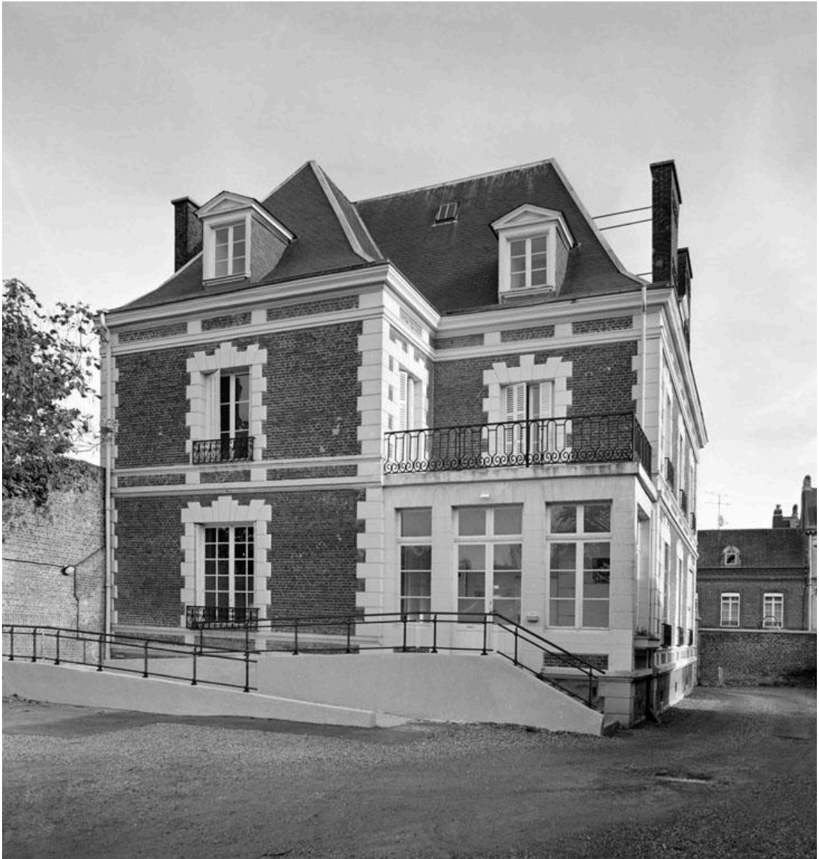
Vue de la façade postérieure sur jardin.
