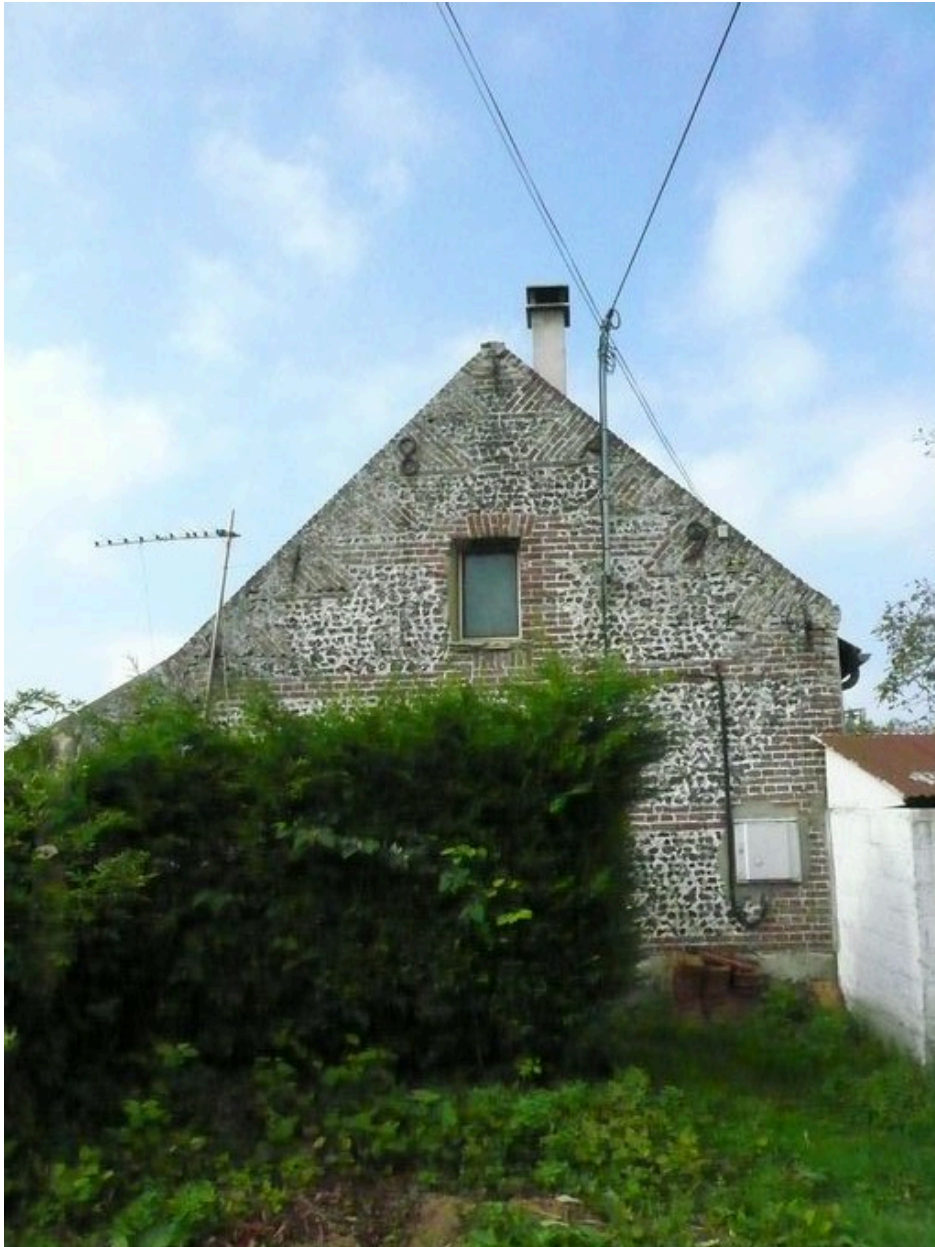
Vue du pignon sur rue, daté de 1849.
