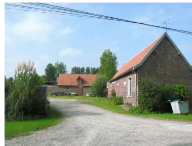
Vue des dépendances. Phot. Inès Guérin IVR22_20078006234NUCA
