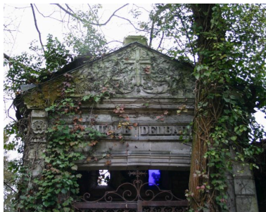
Détail du fronton triangulaire. Phot. Caroline Vincent IVR22_20098000647NUCA
