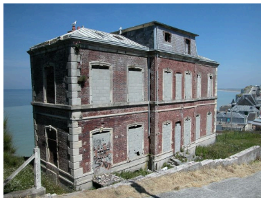
Vue d'ensemble, façade postérieure. Phot. Elisabeth Justome IVR22_20058003362NUCA
