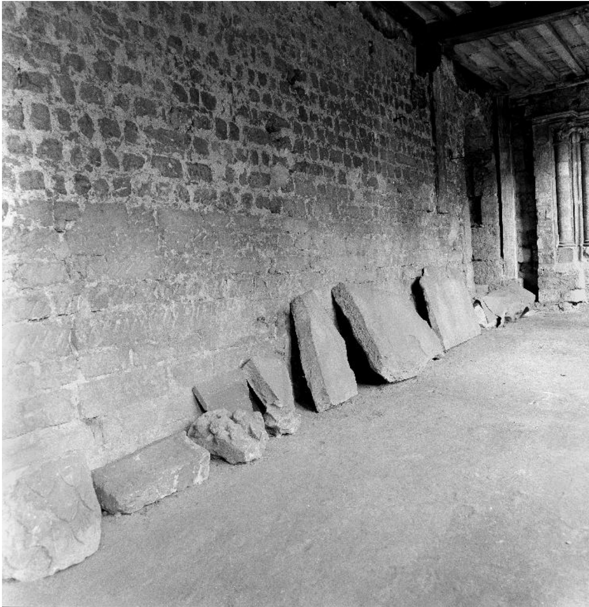
Dépôt lapidaire sous le cloître : vue d'ensemble du dépôt principal sous l'auvent sud.
