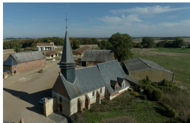
Vue générale et aérienne de l'église. Phot. Marc Kérignard IVR32_20226001095NUCA
