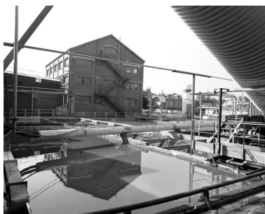
Les bassins de décantation construits dans les années 1920 avec, à l'arrière plan, le bâtiment n°4 datant des mêmes années mais non identifié. Phot. Laurent Jumel IVR22_19966002594X
