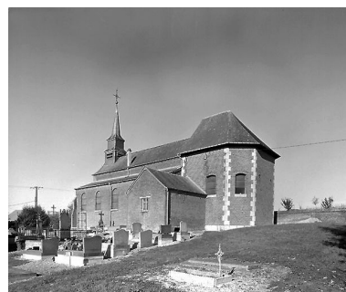
Vue depuis le sud-est. Phot. Laurent Jumel IVR22_19970201880V
