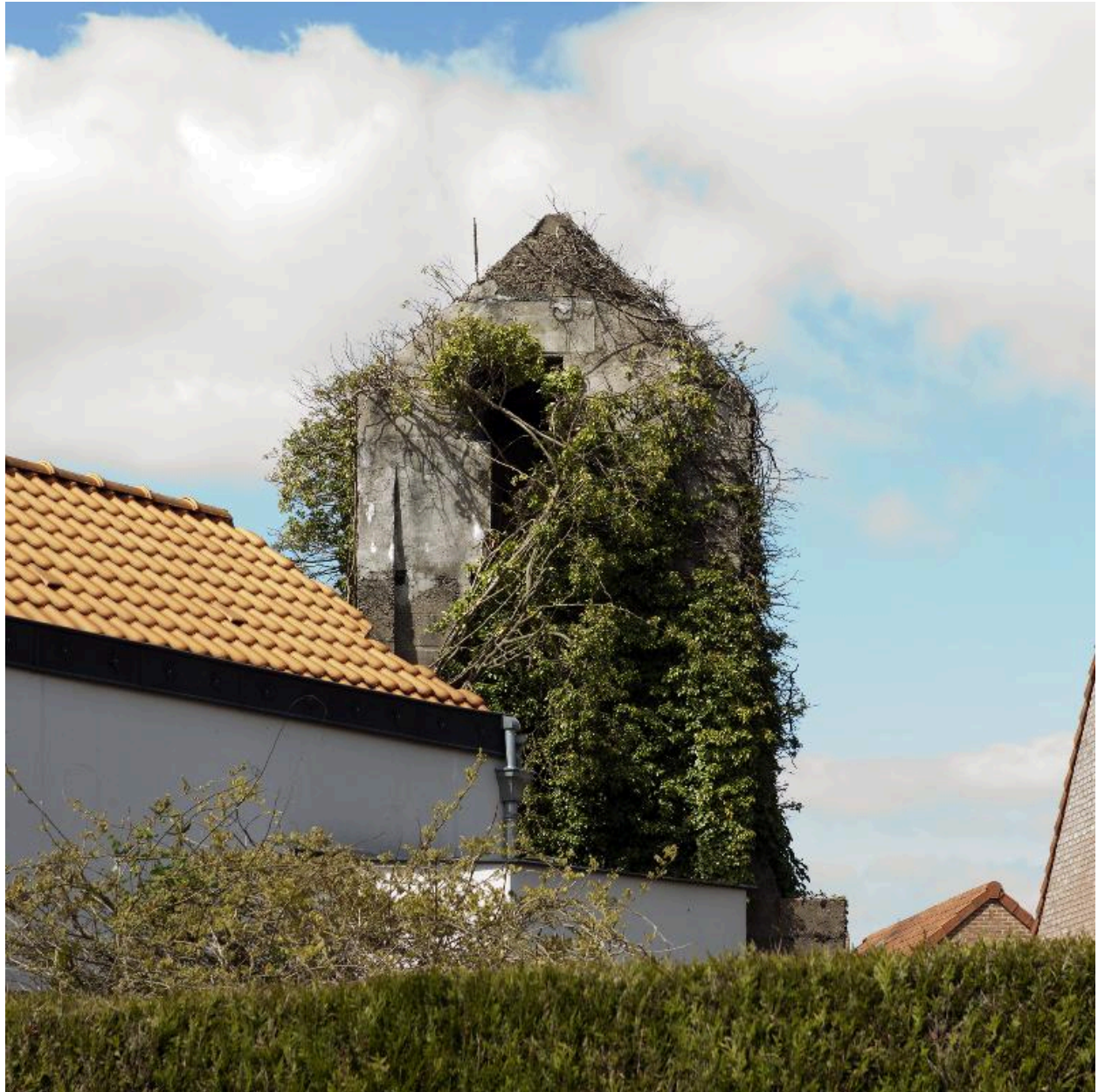
Tour casematée depuis la rue
