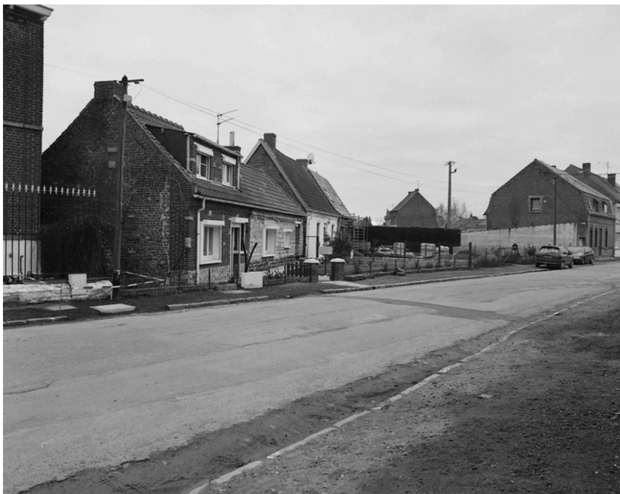
Maisons élémentaires en alignement, côté est de la place.
