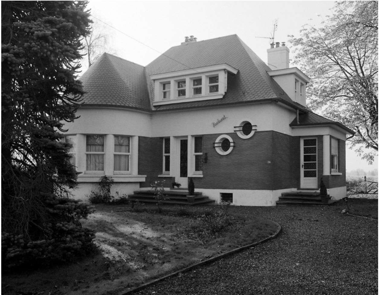
Vue générale, 218 rue Richon.
