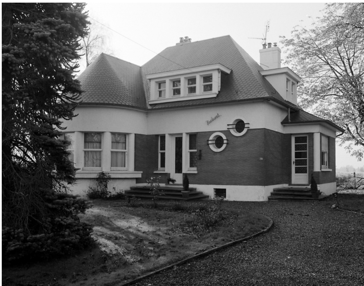
Vue générale, 218 rue Richon.
