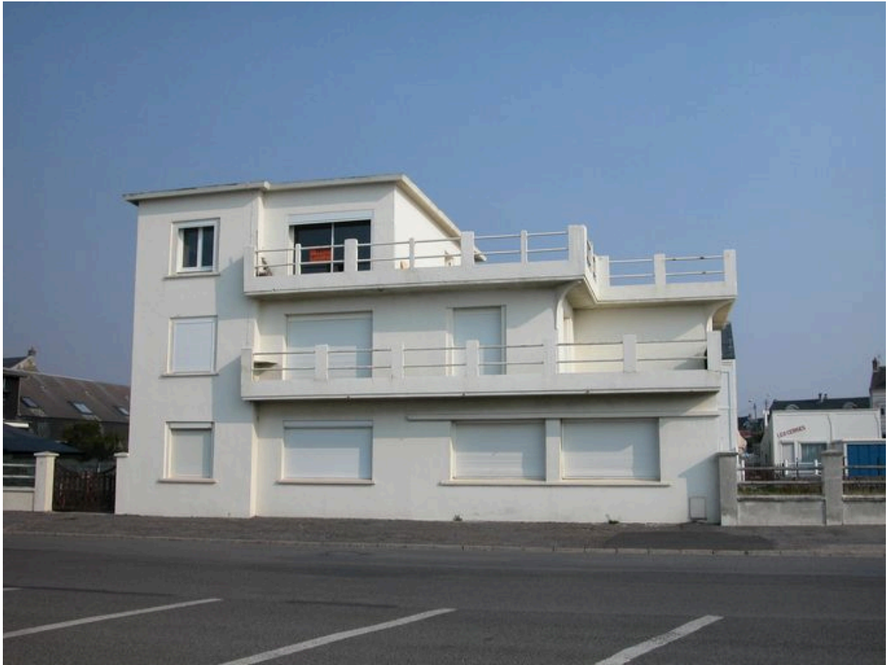
Vue d'ensemble, façade antérieure sur mer.
