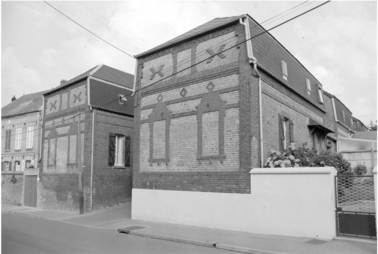
Vue des logements imposés comme constructions neuves en 1899, depuis la rue Henri-Barbusse, en 1990.
