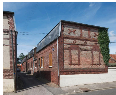
Vue de la rive est de l'impasse des Serruriers, depuis la rue Henri-Barbusse. Phot. Thierry Lefébure IVR22_20128000823NUC2AQ
