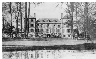
Etat avant 1914 (AP). Phot. Jean-Michel Périn IVR22_19856000349XB
