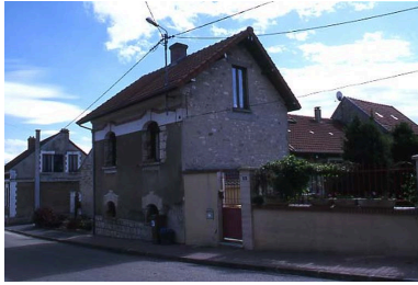
Vue générale. Phot. Inès Guérin IVR22_20030203198NUCA
