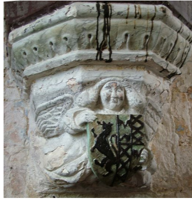
Détail de la console.
