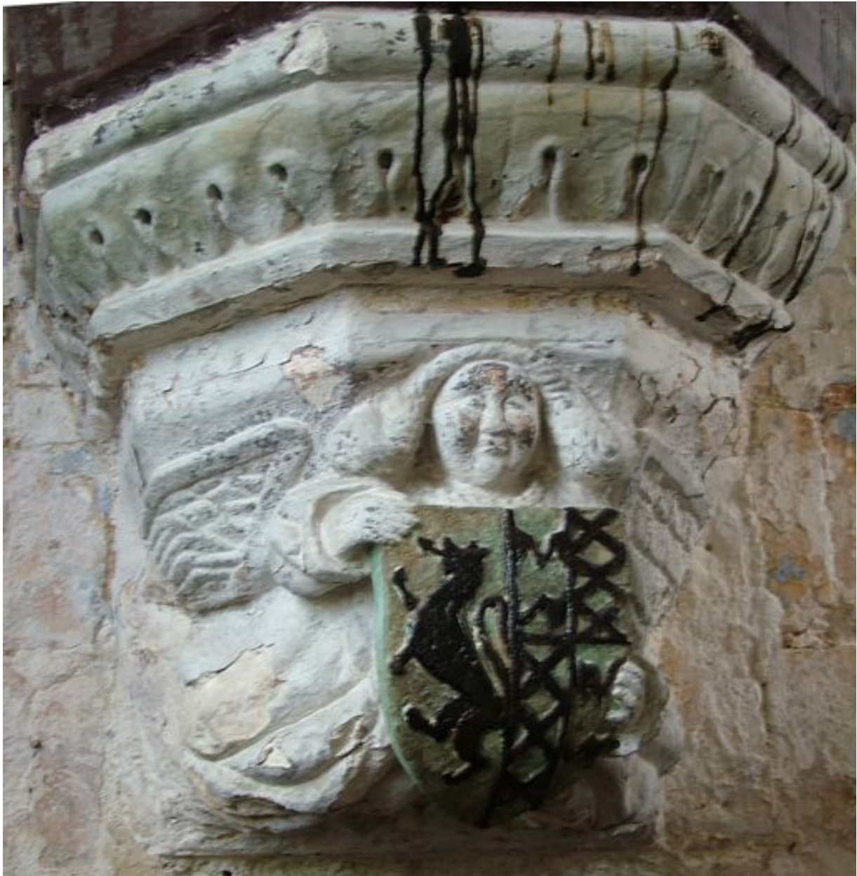
Détail de la console.
