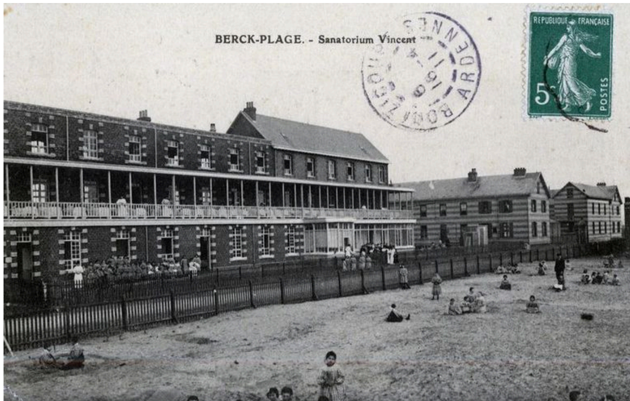
Elévation des divers corps de bâtiment sur le chemin des Anglais, vue générale prise de trois-quarts gauche montrant le bâtiment situé au nord de l'édifice primitif avec sa nouvelle extension, pourvu alors d'une galerie de cure seulement au premier étage. Carte postale, 1er quart 20e siècle (coll. part.).
