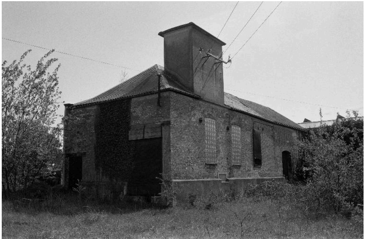
Chaufferie (?) et transformateur.
