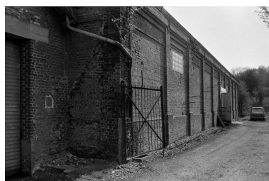
Logements ouvriers rue de Hurlevent. Phot. Benoît Dufournier
