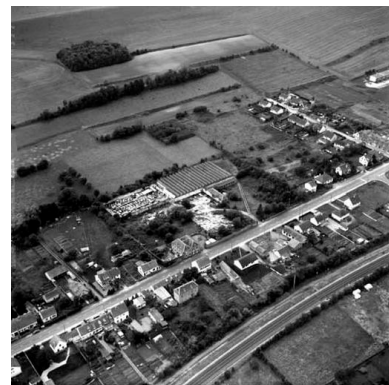
Vue aérienne, flanc nord. Phot. Phot'R
