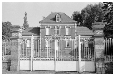
Vue du logis en 1990. Phot. Francis Dubuc IVR22_19908000470Z
