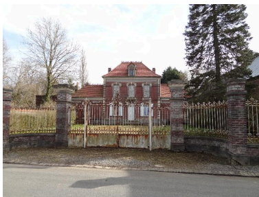
Vue du logis depuis la rue de Martaigneville. Phot. Frédéric-Nicolas Kocourek IVR22_20158005101NUCA
