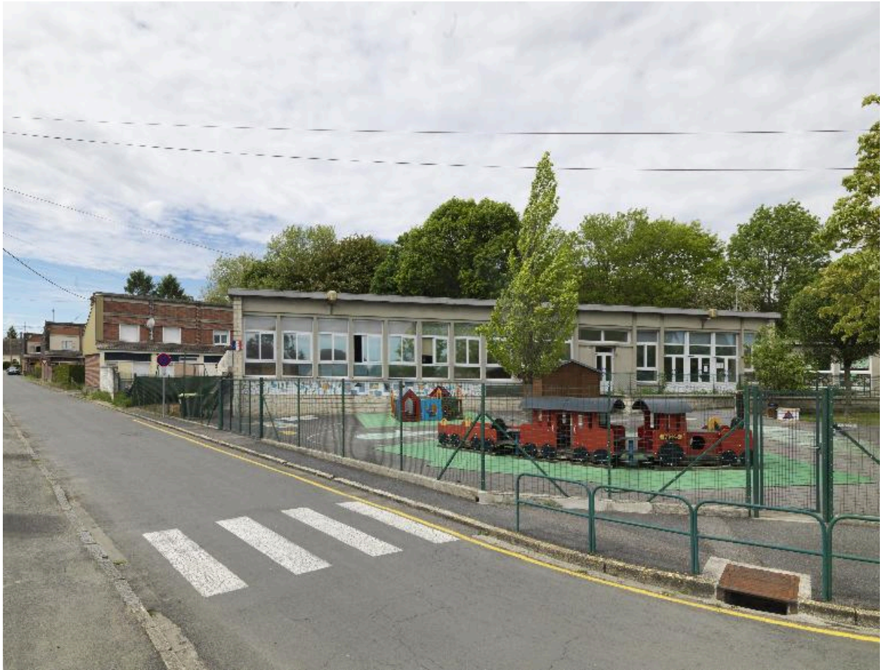
Vue des nouvelles classes construites vers 1960.
