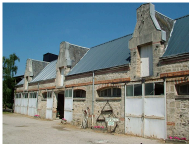
Vue des bâtiments agricoles. Phot. Inès Guérin IVR22_20030202953NUCA
