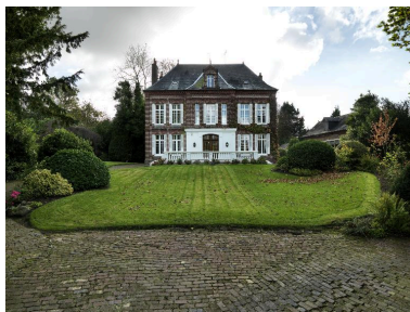
Vue générale depuis la cour. Phot. Thierry Lefébure IVR22_20148000640NUC2A
