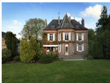
Vue de la façade postérieure. Phot. Thierry Lefébure IVR22_20148000637NUC2A
