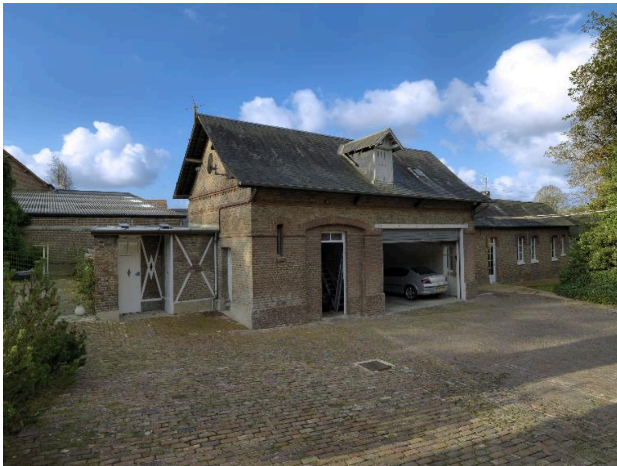
Vue de trois-quarts des garages, du logement du gardien ainsi que des cabinets d'aisance.
