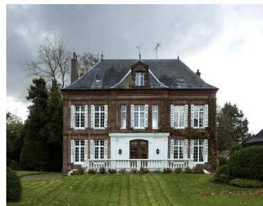
Vue de la façade principale. Phot. Thierry Lefébure IVR22_20148000641NUC2A
