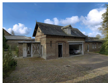
Vue de trois-quarts des garages, du logement du gardien ainsi que des cabinets d'aisance. Phot. Thierry Lefébure IVR22_20148000639NUC2A
