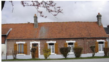
Vue de face du logis.
