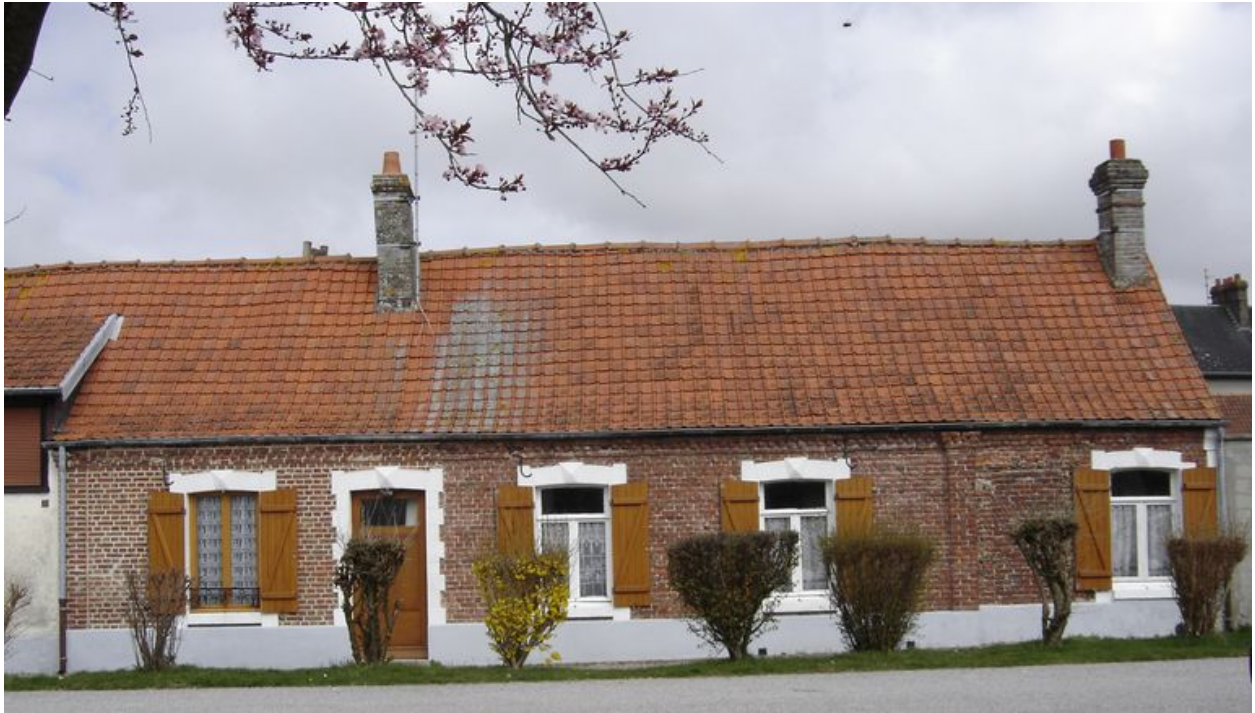
Vue de face du logis.
