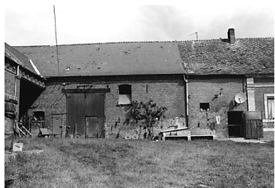
Etable à vaches et à chevaux attenante au logis. Phot. Laurent Jumel IVR22_19980201771X
