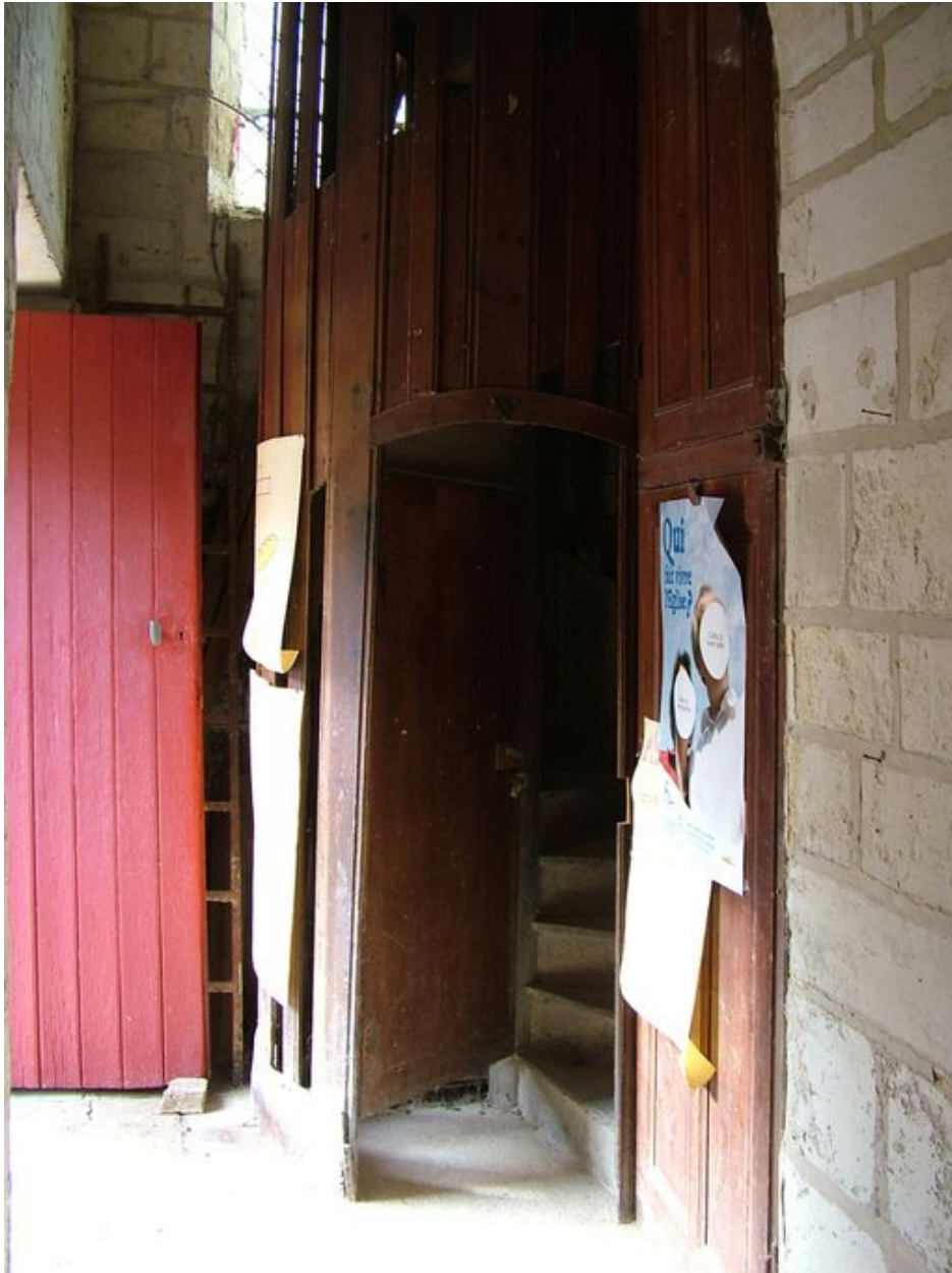
Départ de l'escalier en vis construit près de l'entrée latérale sud, chêne, 19e siècle.
