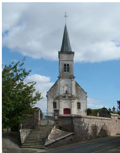
Vue générale de l'église depuis l'ouest. Phot. Frédéric Fournis IVR22_20098005513NUCA
