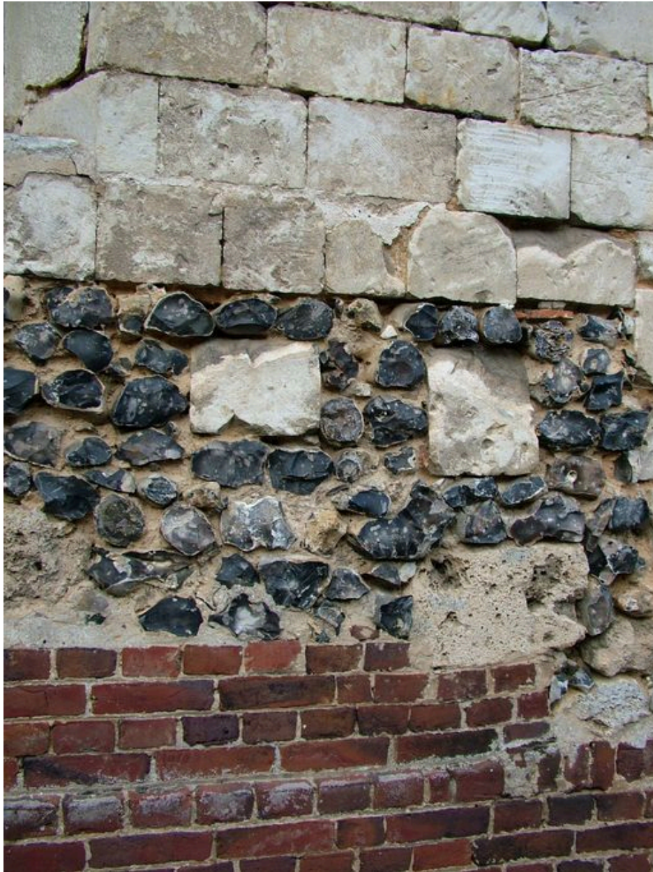
Détail de l'appareil de la partie inférieure du mur sud.
