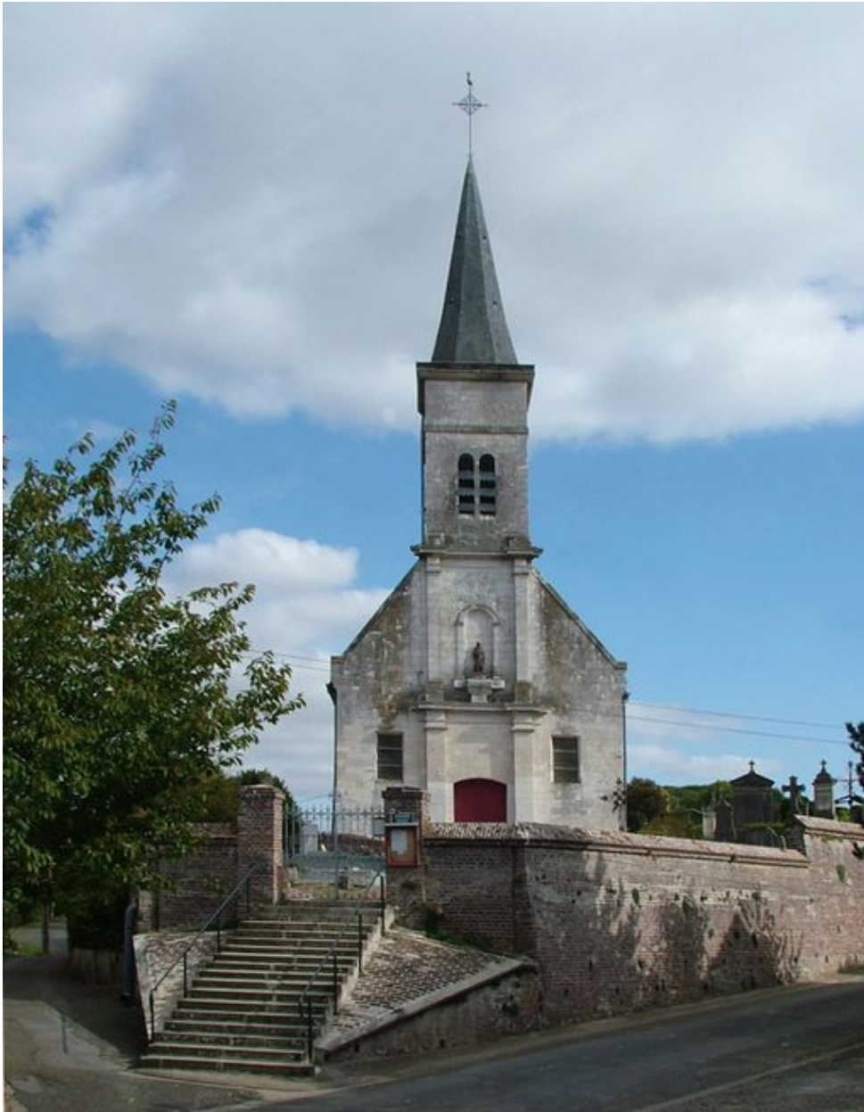
Vue générale de l'église depuis l'ouest.
