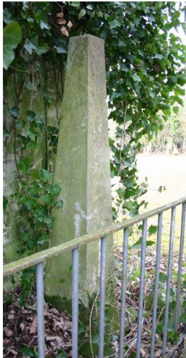
Tombeau (obélisque), vers 1839. Phot. Caroline Vincent IVR22_20098000754NUCA
