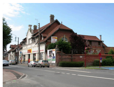
Vue d'ensemble, de trois-quarts sur rue. Phot. Bertrand Fournier IVR22_20138016069NUC2AQ
