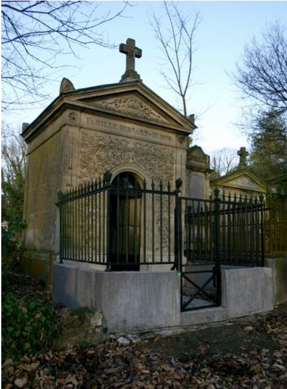
Vue générale, depuis le côté.
