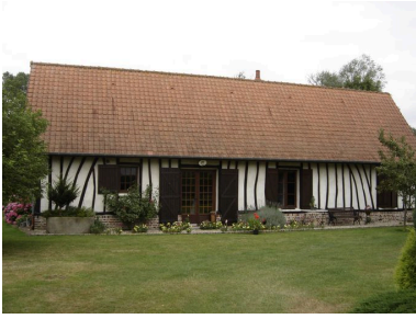
Vue générale. Phot. Inès Guérin IVR22_20068005072NUCA
