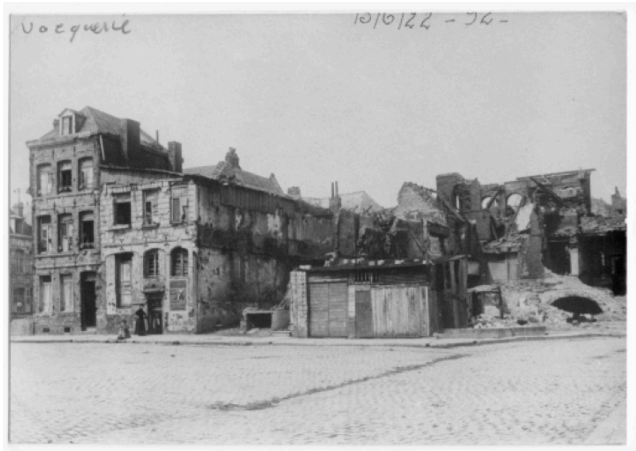
Arras. Place de la Vacquerie. Photographie, 1922 (Médiathèque d'Arras ; 187).
