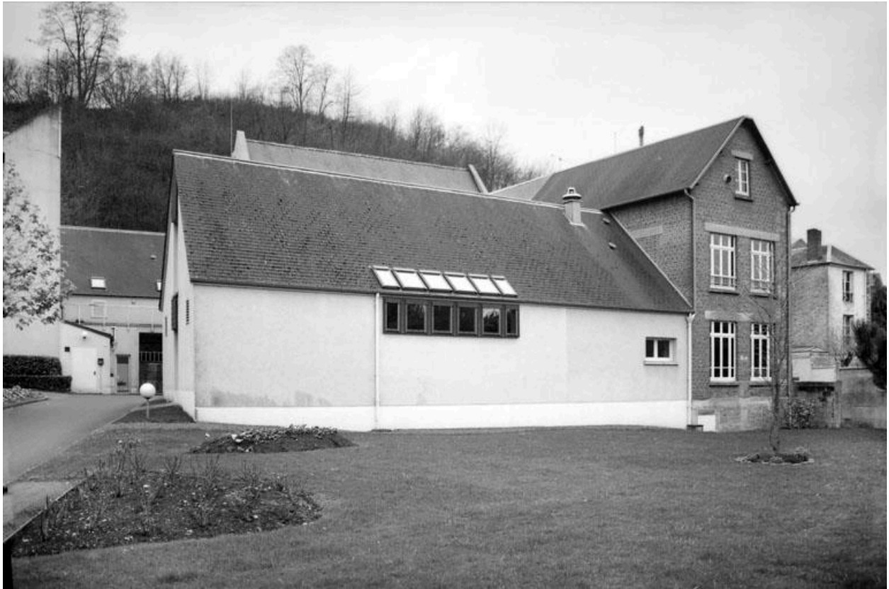
Vue des bâtiments, depuis l'arrière.
