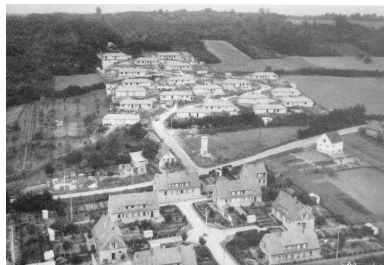
Vue générale des cités Entreil (en bas) et l'Epine, vers 1960 (AC Villers-Saint-Paul). Phot. Clarisse Lorieux IVR22_20096005101NUCAB
