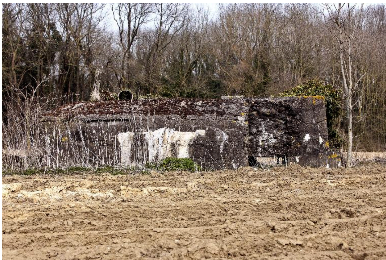
Vue générale vers le nord-est
