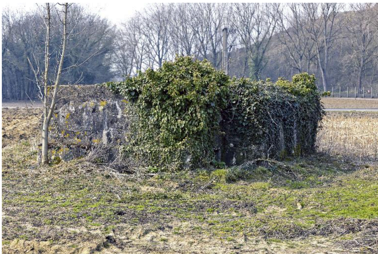
Vue générale vers le sud-ouest
