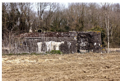
Vue générale vers le nord-est Phot. Jean-Marc Ramette IVR31_20145904005NUCA
