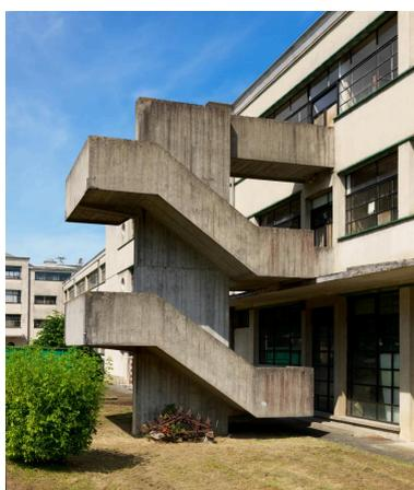
Détail de l'escalier hors-œuvre en béton armé.
