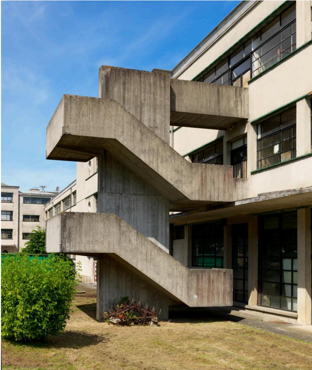
Détail de l'escalier hors-œuvre en béton armé.
