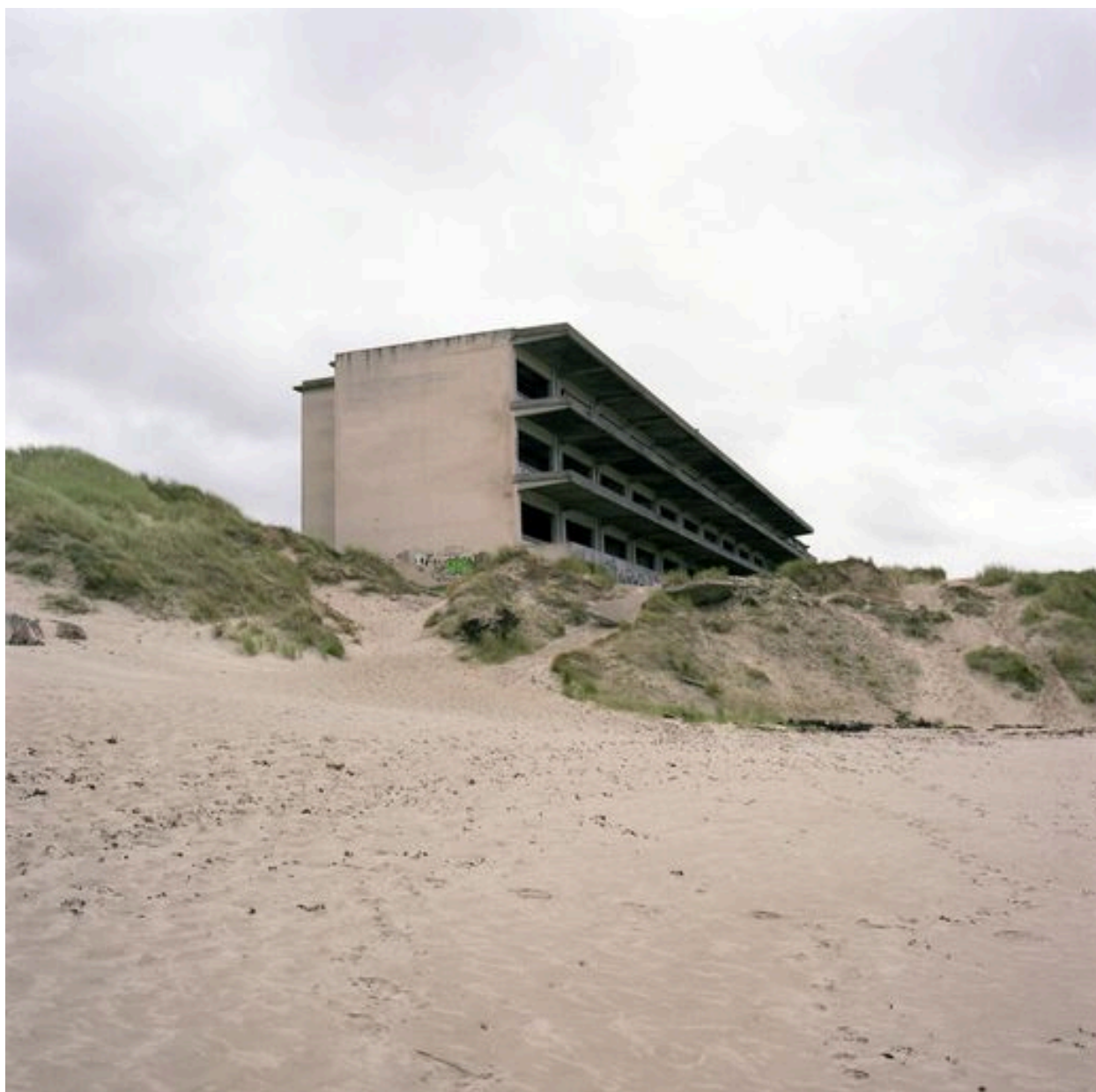
Elévation antérieure, vue générale prise en enfilade depuis le nord.
