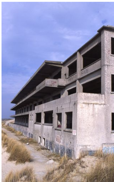
Elévation antérieure, vue générale prise en enfilade à partir du flanc droit. Phot. Pierre-Louis Laget IVR31_20066200331ZA
