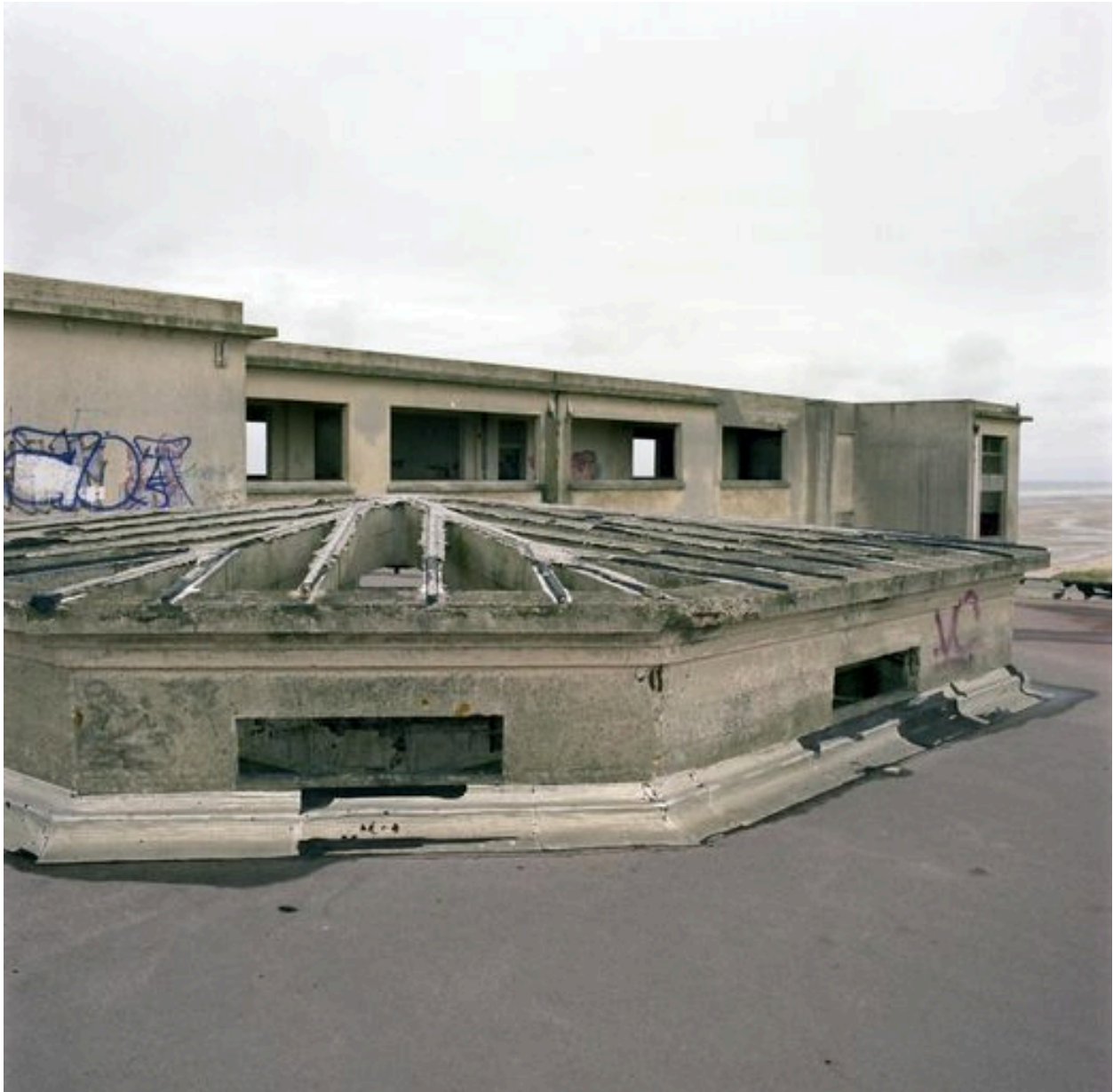
Aile devant renfermer les services médico-techniques, située sur l'arrière du bâtiment d'hospitalisation, couverture de la salle d'opération, vue prise de l'extérieur.
