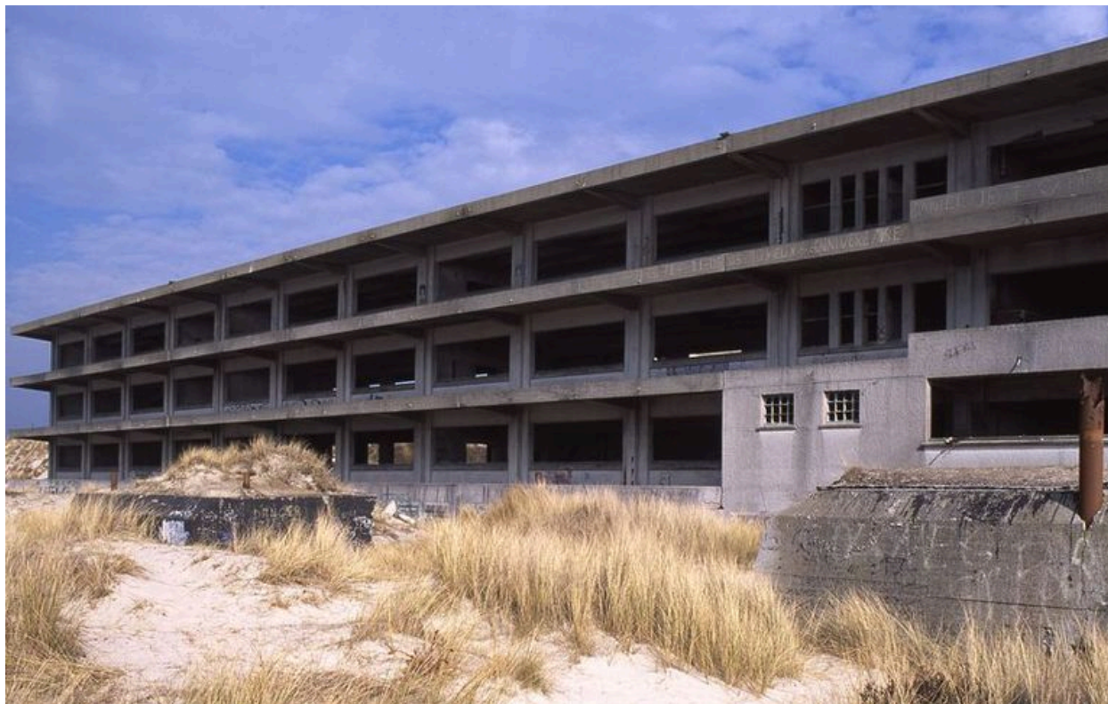
Elévation antérieure, vue générale prise de trois-quarts droit.
