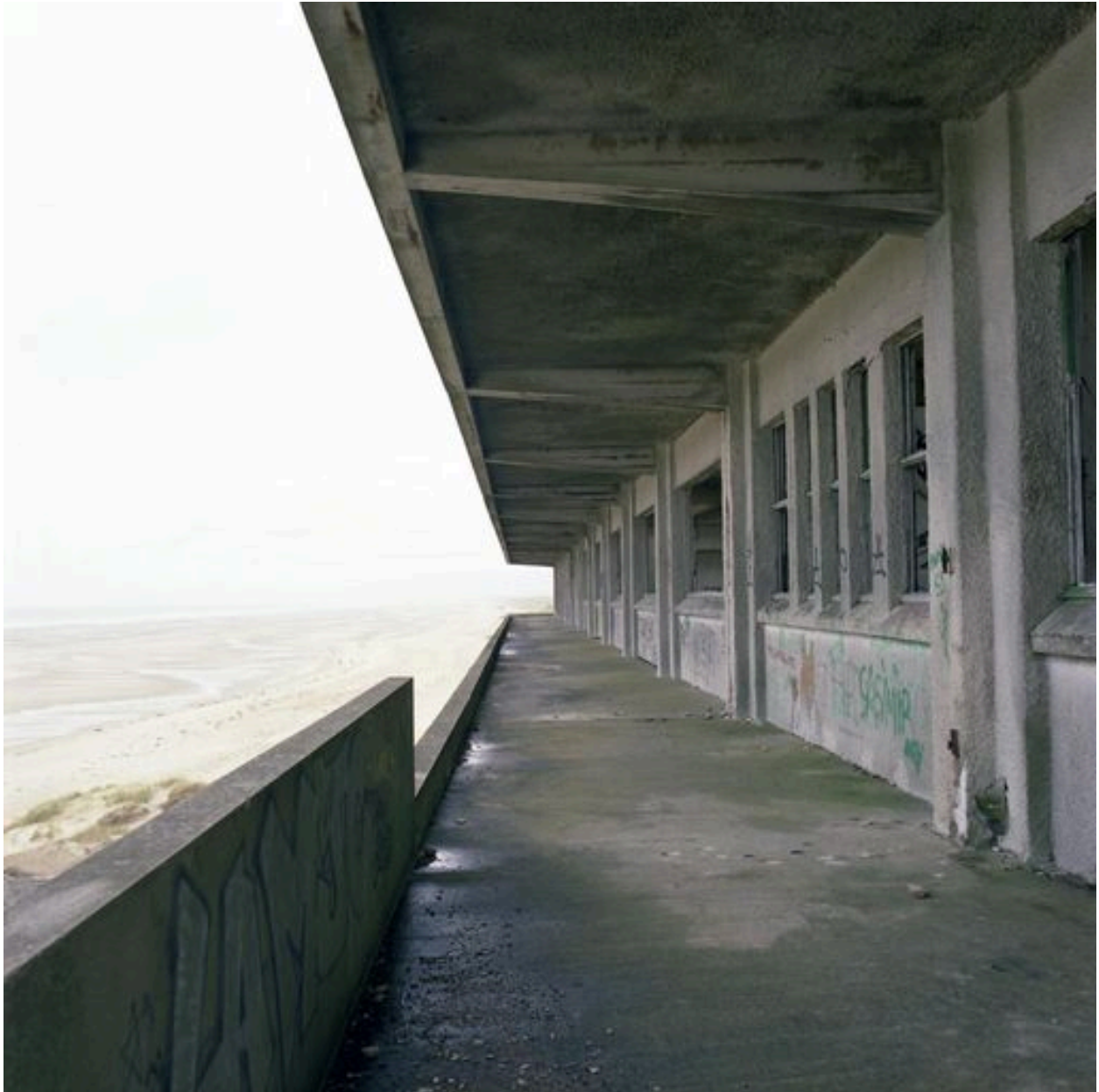
Elévation antérieure, galerie de cure d'un des étages, vue en enfilade.
