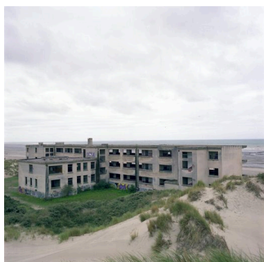
Elévation postérieure, vue générale prise de trois-quarts droit. Phot. Pierre Thibaut
