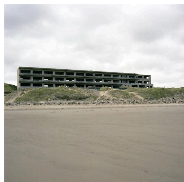
Élévation antérieure, vue générale prise de face. Phot. Pierre Thibaut
