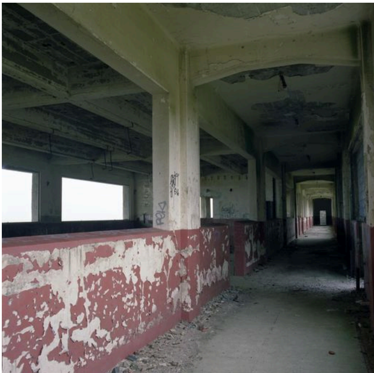
Couloir de distribution desservant un des étages, vue en enfilade.
