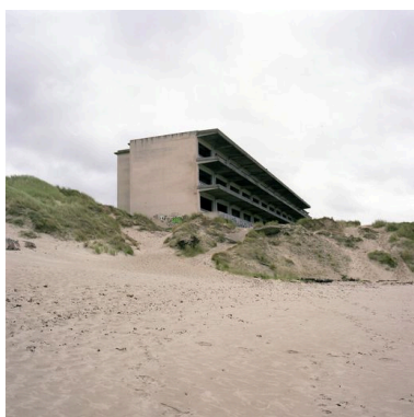
Elévation antérieure, vue générale prise en enfilade depuis le nord. Phot. Pierre Thibaut
