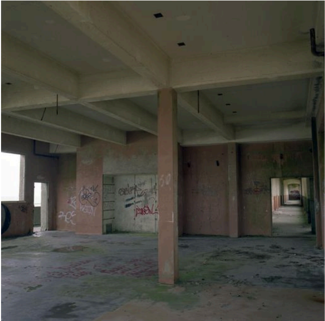
Salle située à l'un des étages, au centre du bâtiment d'hospitalisation, vue générale montrant l'enfilade du couloir de distribution des chambres.
