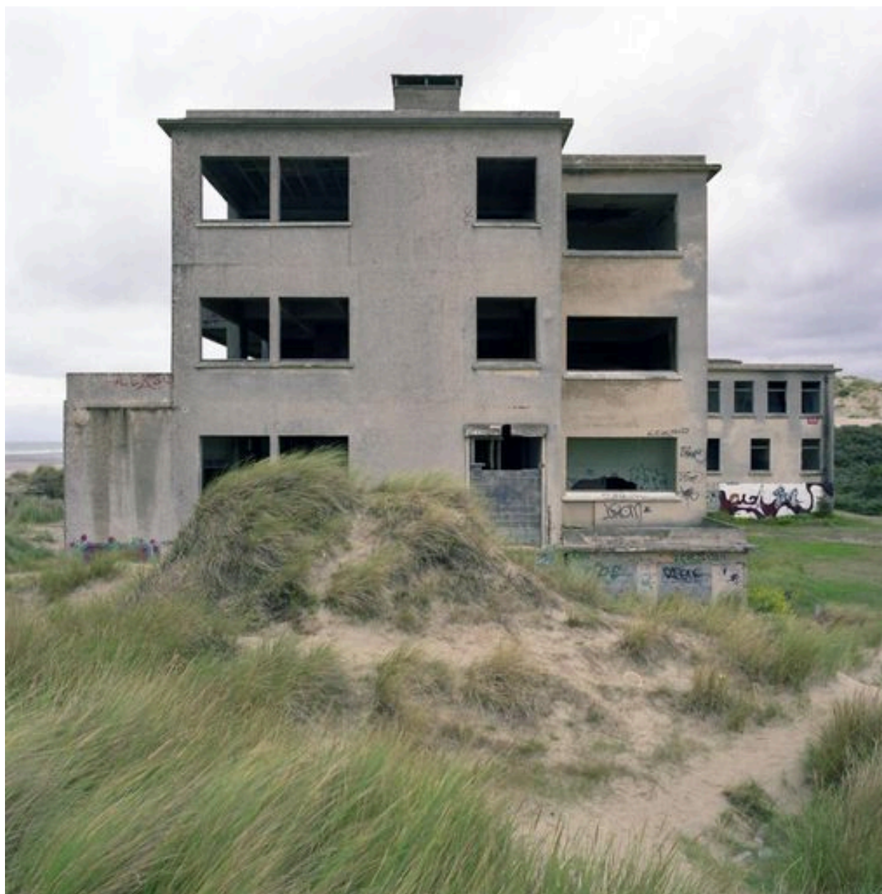
Elévation latérale sud, vue générale.
