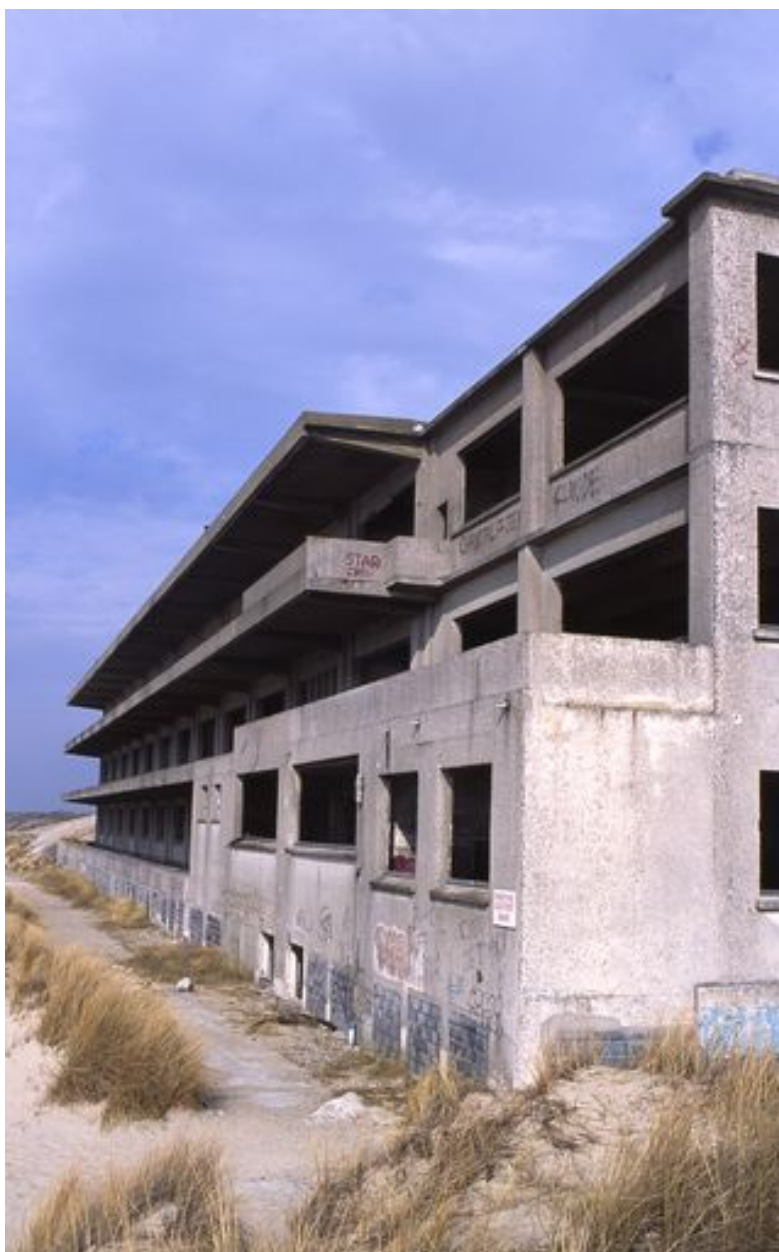
Elévation antérieure, vue générale prise en enfilade à partir du flanc droit.
