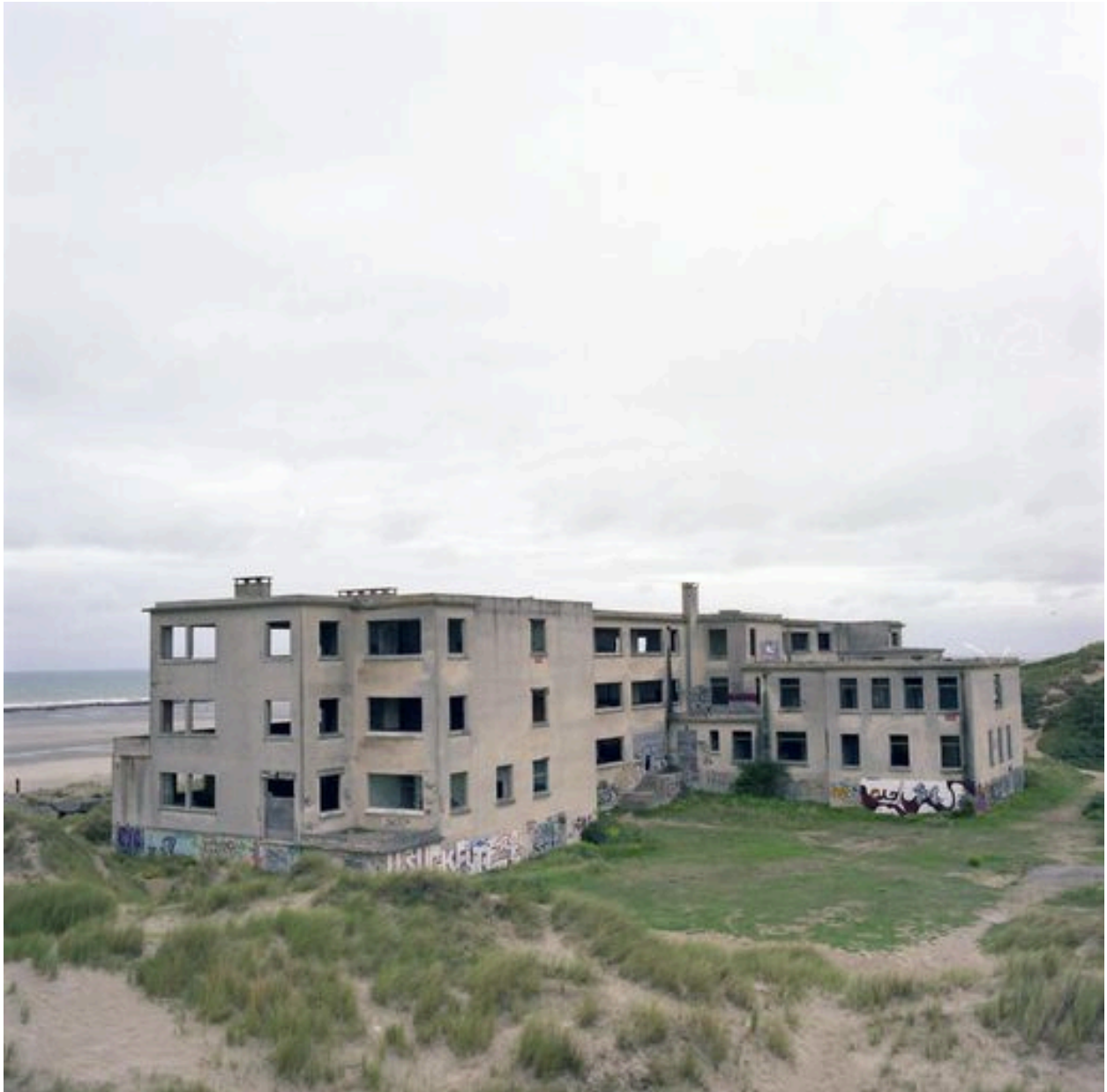
Elévation postérieure, vue générale prise de trois-quarts gauche.
