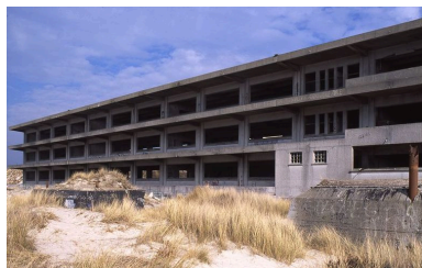
Elévation antérieure, vue générale prise de trois-quarts droit. Phot. Pierre-Louis Laget IVR31_20066200330ZA
