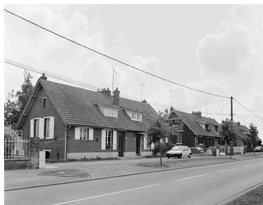
Logements d'ouvriers. Phot. Patrick Glotain IVR22_199360000808X
