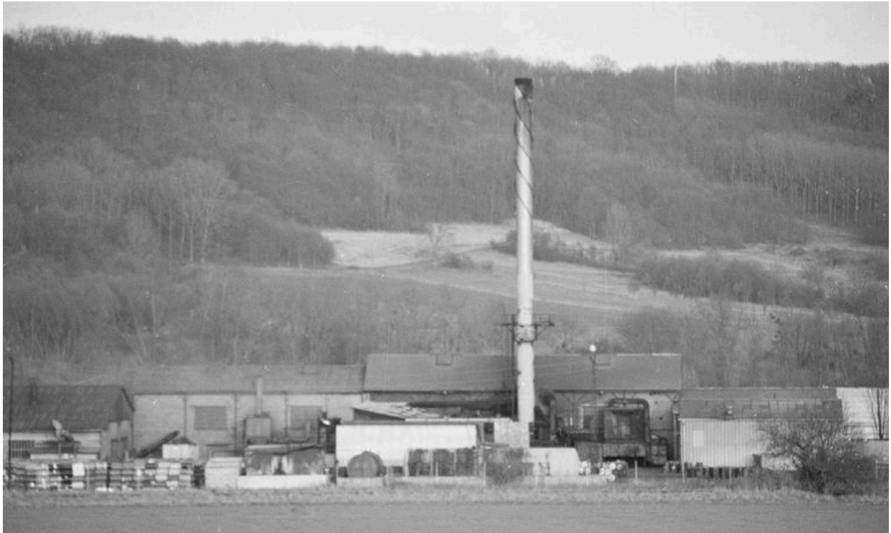
Bâtiments de l'usine et cheminée à fût métallique.
