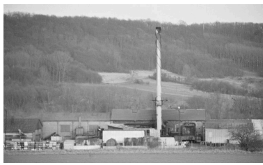
Bâtiments de l'usine et cheminée à fût métallique. Phot. Benoît Dufournier IVR22_19936000012Z
