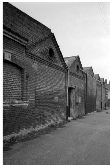
Atelier de fabrication et entrepôts industriels, flanc ouest. Phot. Benoît Dufournier IVR22_19898000526Z
