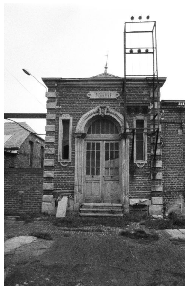
Salle des machines. Phot. Benoît Dufournier IVR22_19898000522Z
