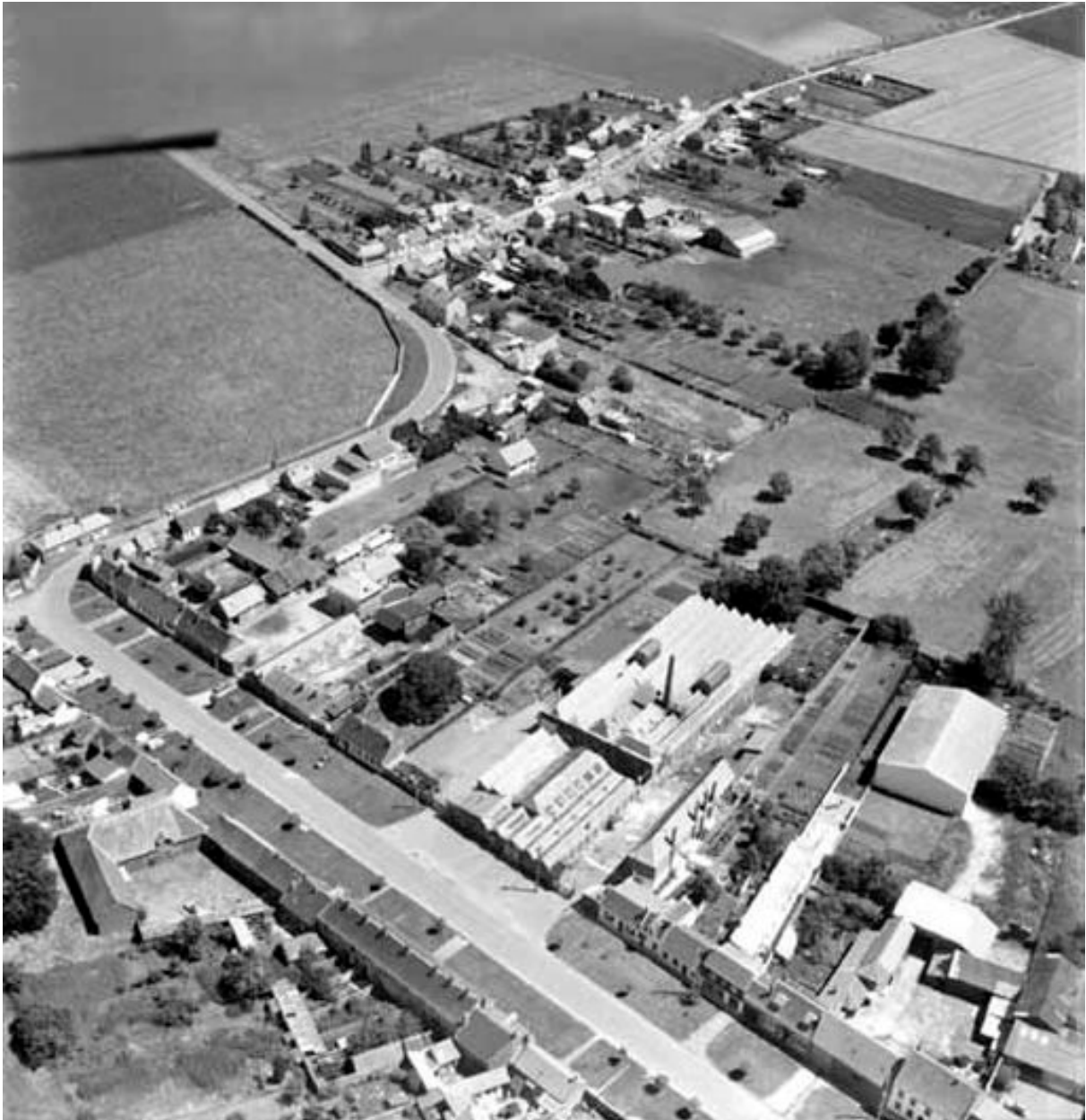
Vue aérienne, flanc sud-ouest.
