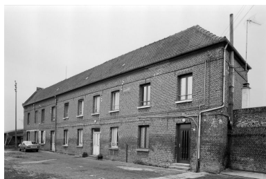
Conciergerie et bureau, flanc nord. Phot. Benoît Dufournier IVR22_19898000527Z
