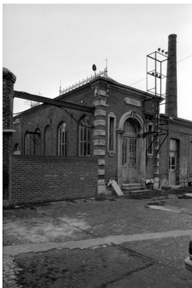
Salle des machines. Phot. Benoît Dufournier IVR22_19898000523Z
